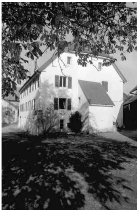
Pignon droit de l'habitation actuelle. 25, Dasle rue du Moulin
