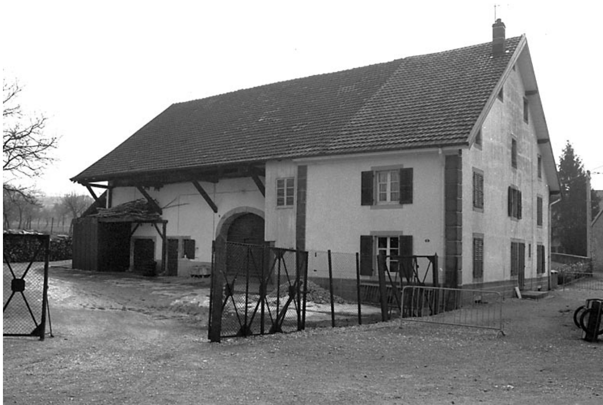
Vue de l'ancien bâtiment d'exploitation.
