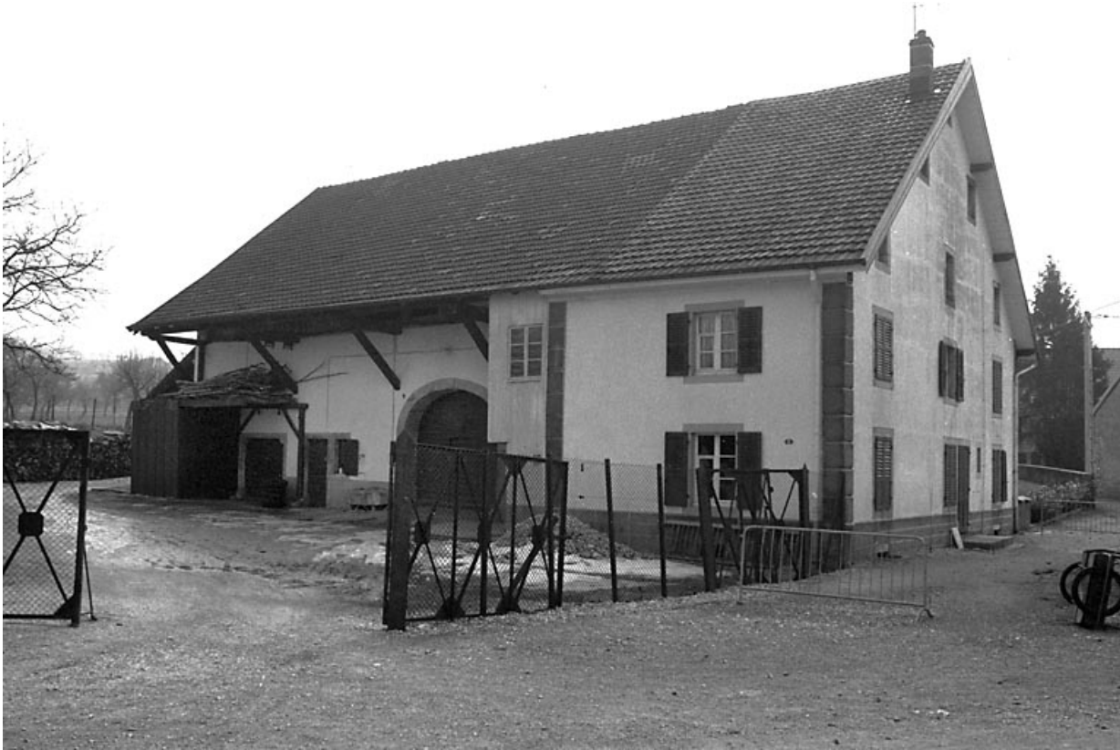
Vue de l'ancien bâtiment d'exploitation.
