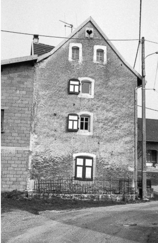
Façade latérale gauche. 25, Dasle impasse des Jardins
