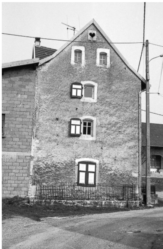
Façade latérale gauche. 25, Dasle impasse des Jardins
