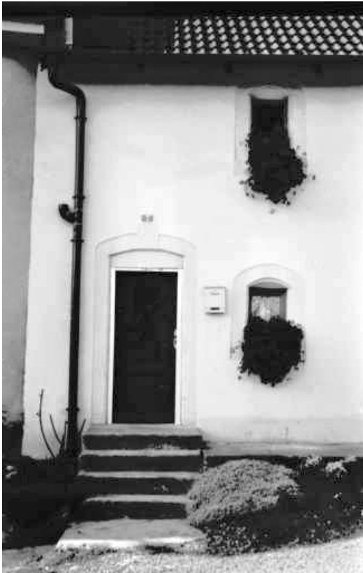
Élévation antérieure : détail.
