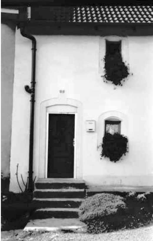
Élévation antérieure : détail.
