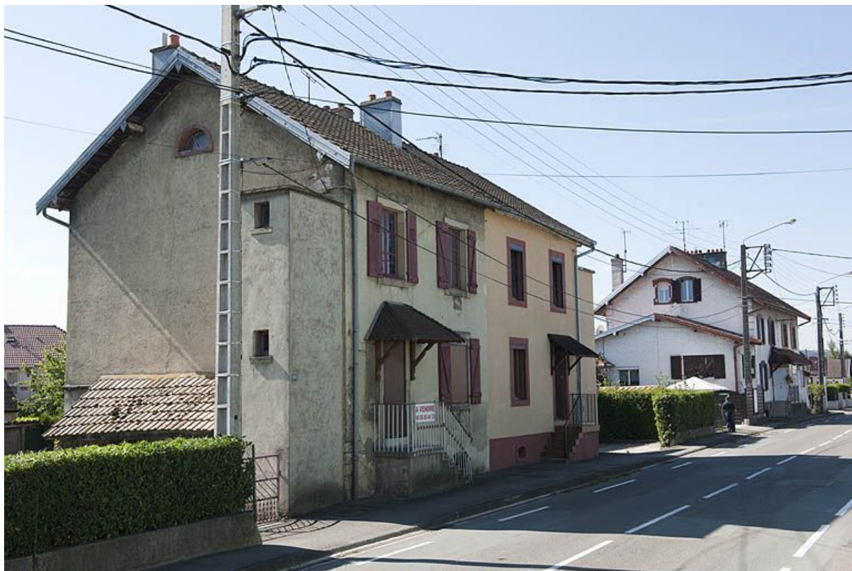
Deux habitations de 4 logements rue des Mines. 25, Audincourt rue Camille Steib
