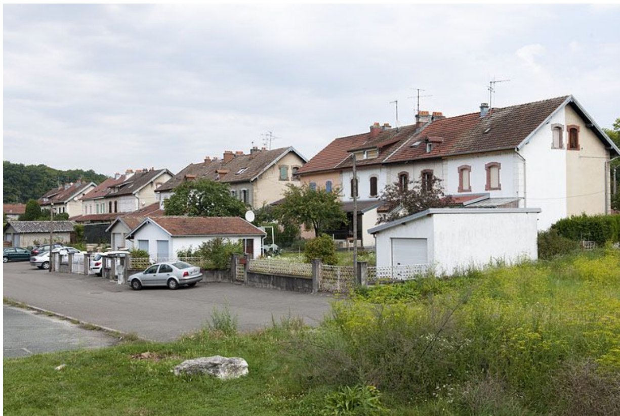
Vue d'ensemble depuis le sud-ouest. 25, Audincourt rue Saglio
