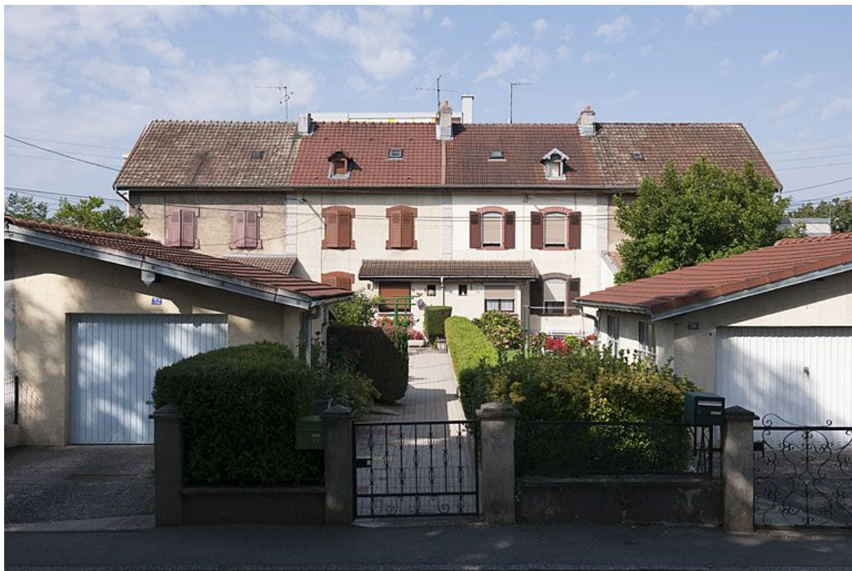
Façade ouest d'une habitation.
