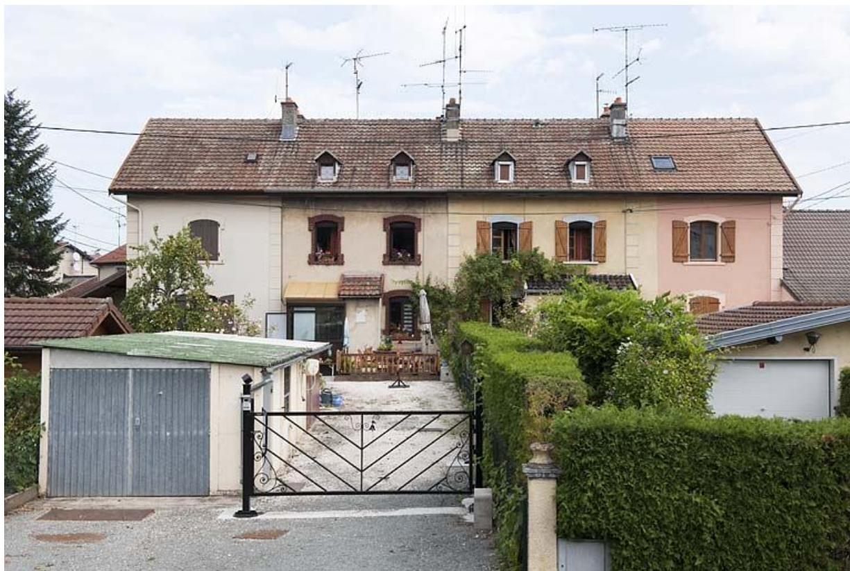
Habitation à 8 logements. Vue de face.
