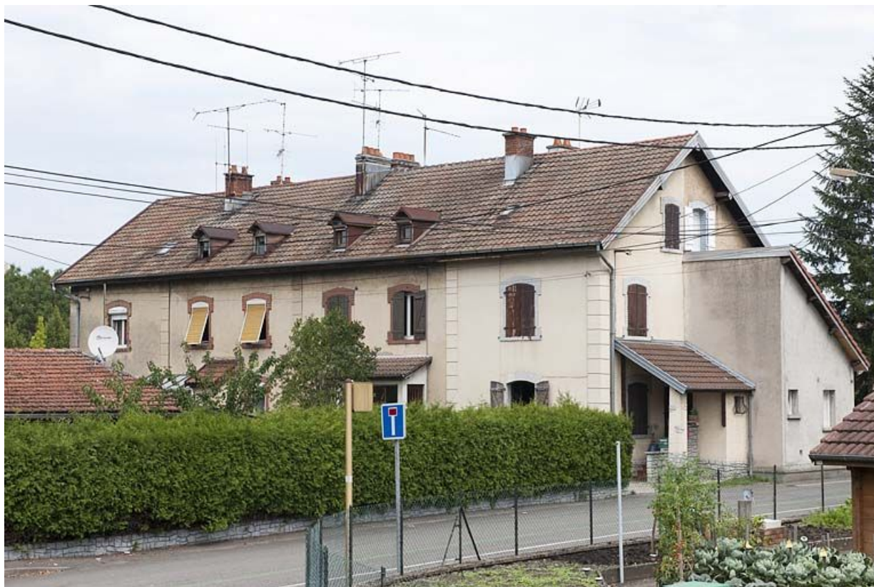
Habitation à 8 logements. Vue depuis le sud. 25, Audincourt avenue du Maréchal Foch
