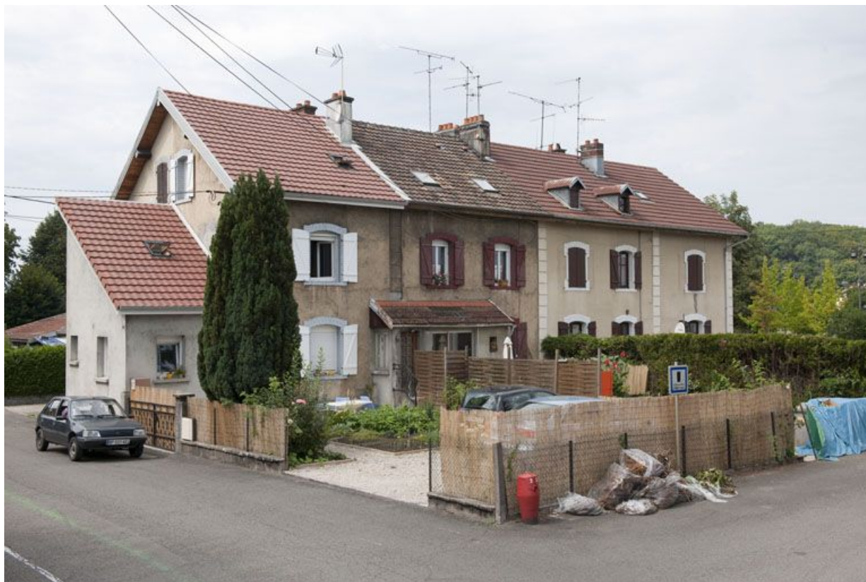
Vue de trois quarts d'une habitation à 8 logements.
