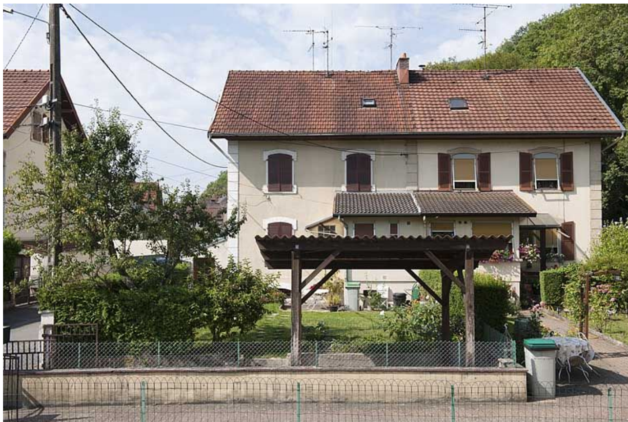
Face est d'une habitation à 4 logements.
