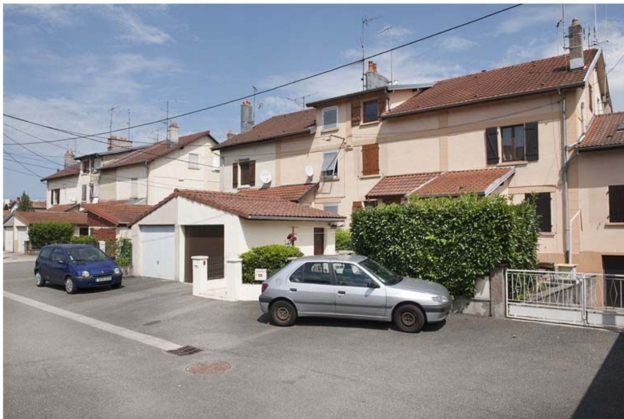
Habitations à 8 logements. Vue de trois quarts.
