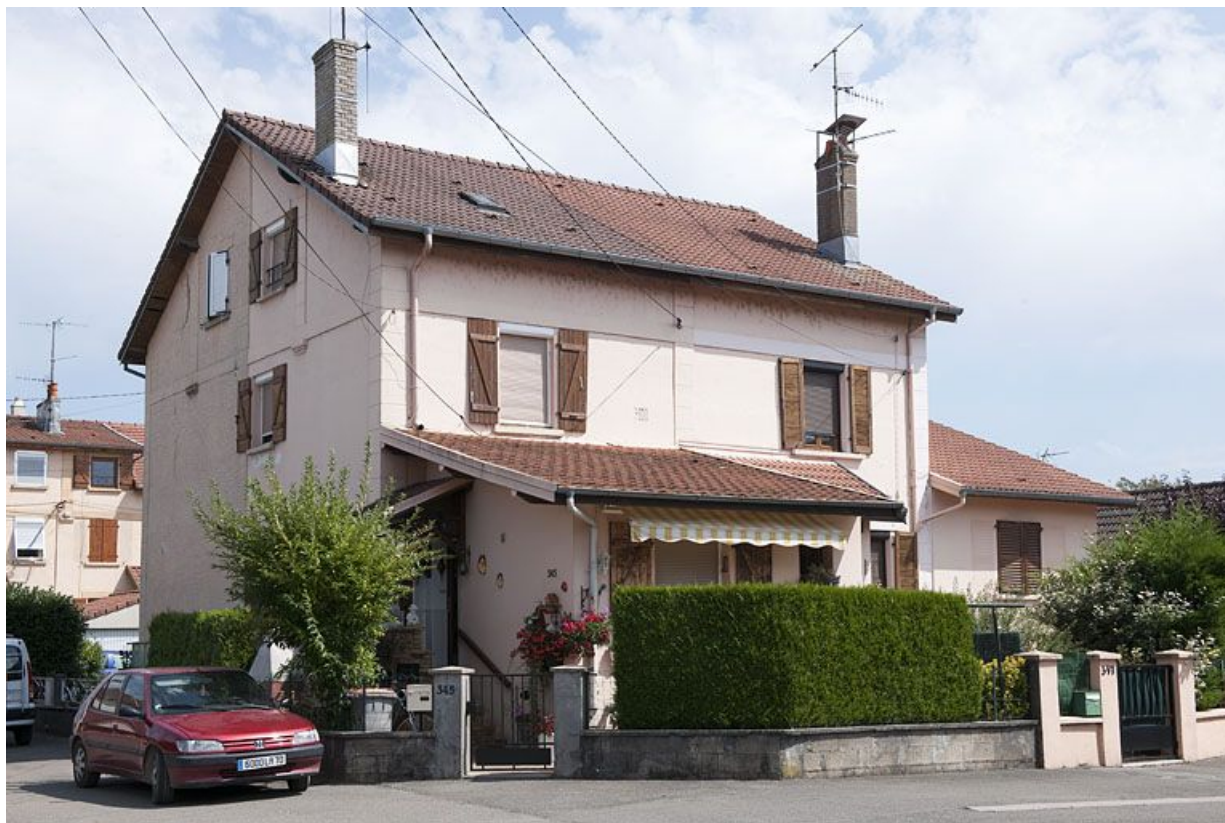
Habitation à 4 logements. Façade ouest. 25, Audincourt rue des Cités Joëssel
