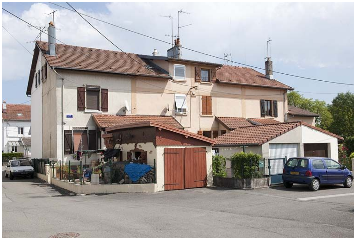
Habitation à 8 logements. Façade ouest. 25, Audincourt rue des Cités Joëssel
