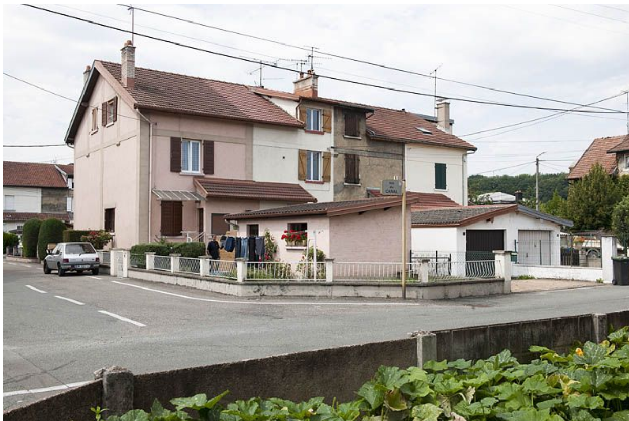
Habitation à 8 logements. Façade est. 25, Audincourt rue des Cités Es Combas
