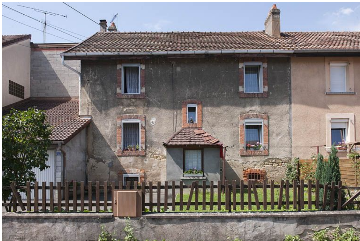
Façade antérieure vue de face.
