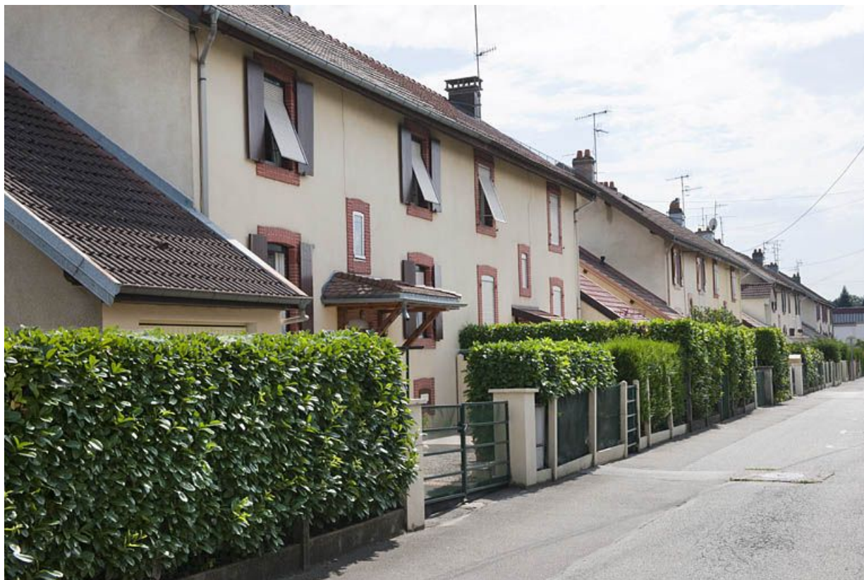
Vue de la rue de la Marne.
