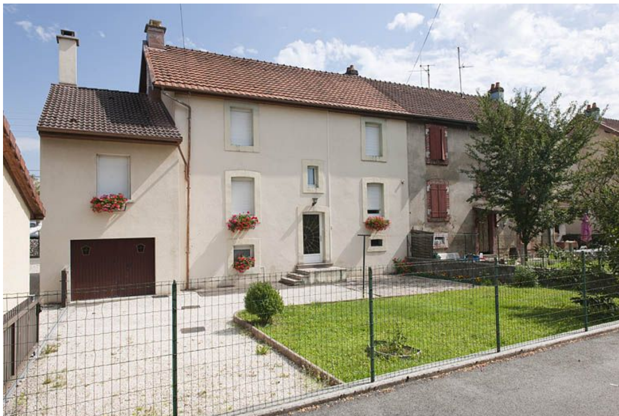
Rue de Verdun. Façade postérieure d'une habitation.
