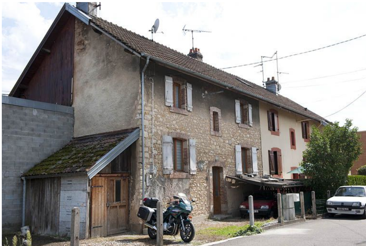
Rue de Verdun. Façade antérieure d'une habitation.
