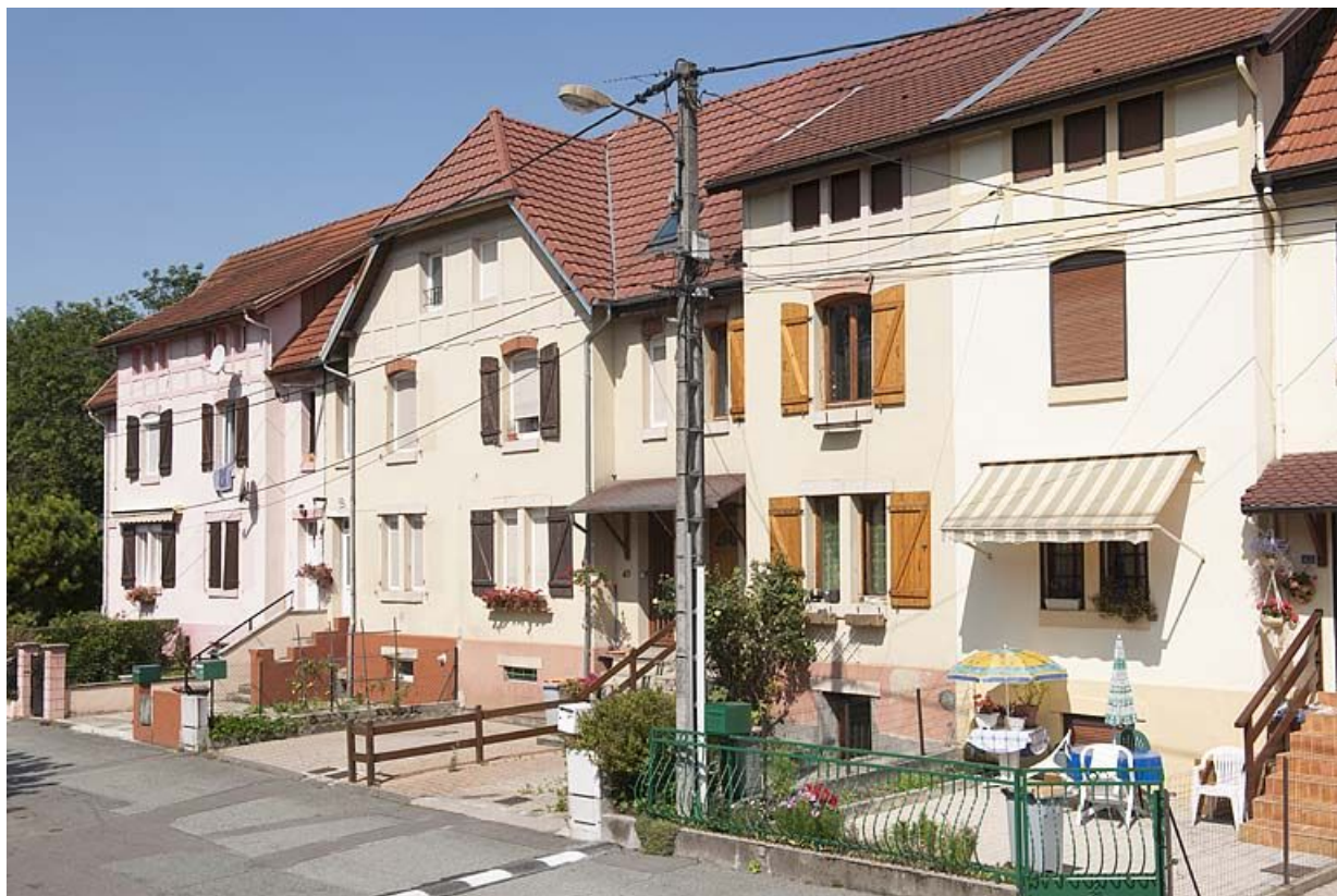
Rue de Somme. Extrémité occidentale de l'immeuble.
