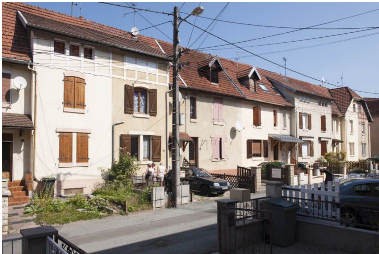
Rue de Somme. Façades nord vues de trois quarts.
