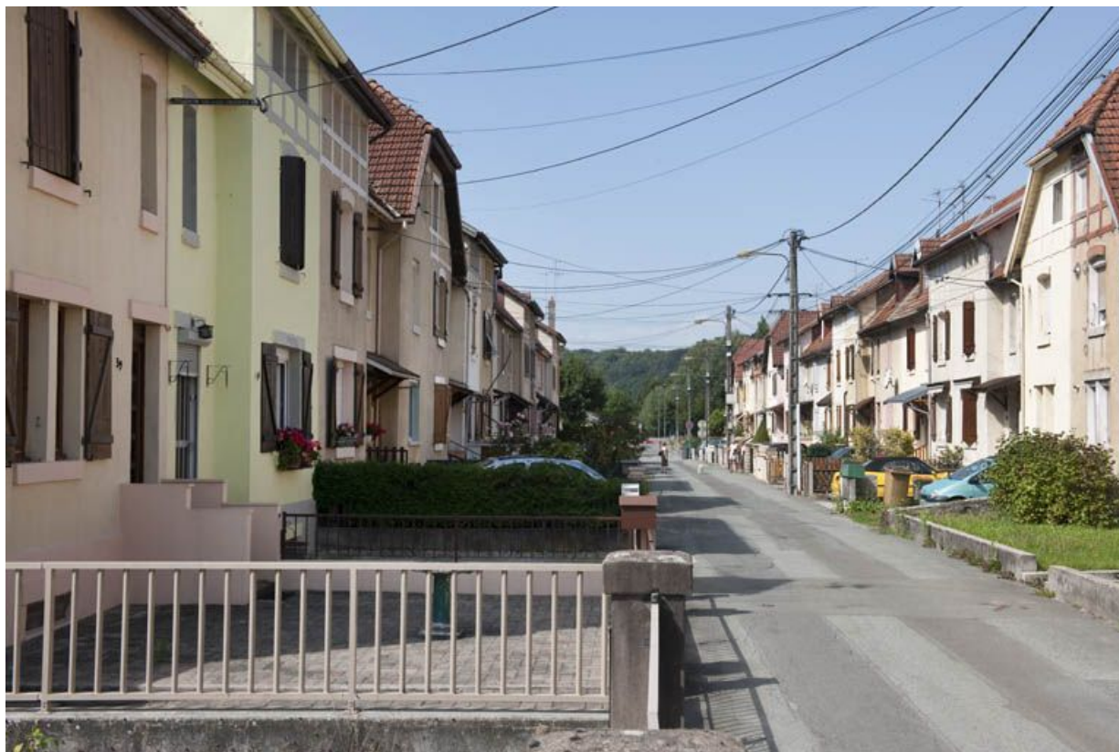
Rue de Somme. Vue d'ensemble.
