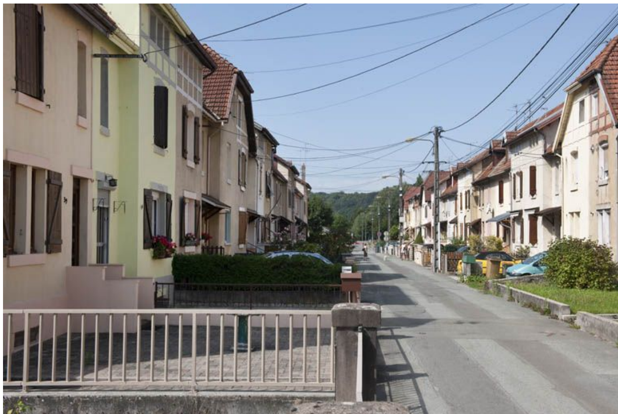
Rue de Somme. Vue d'ensemble.
