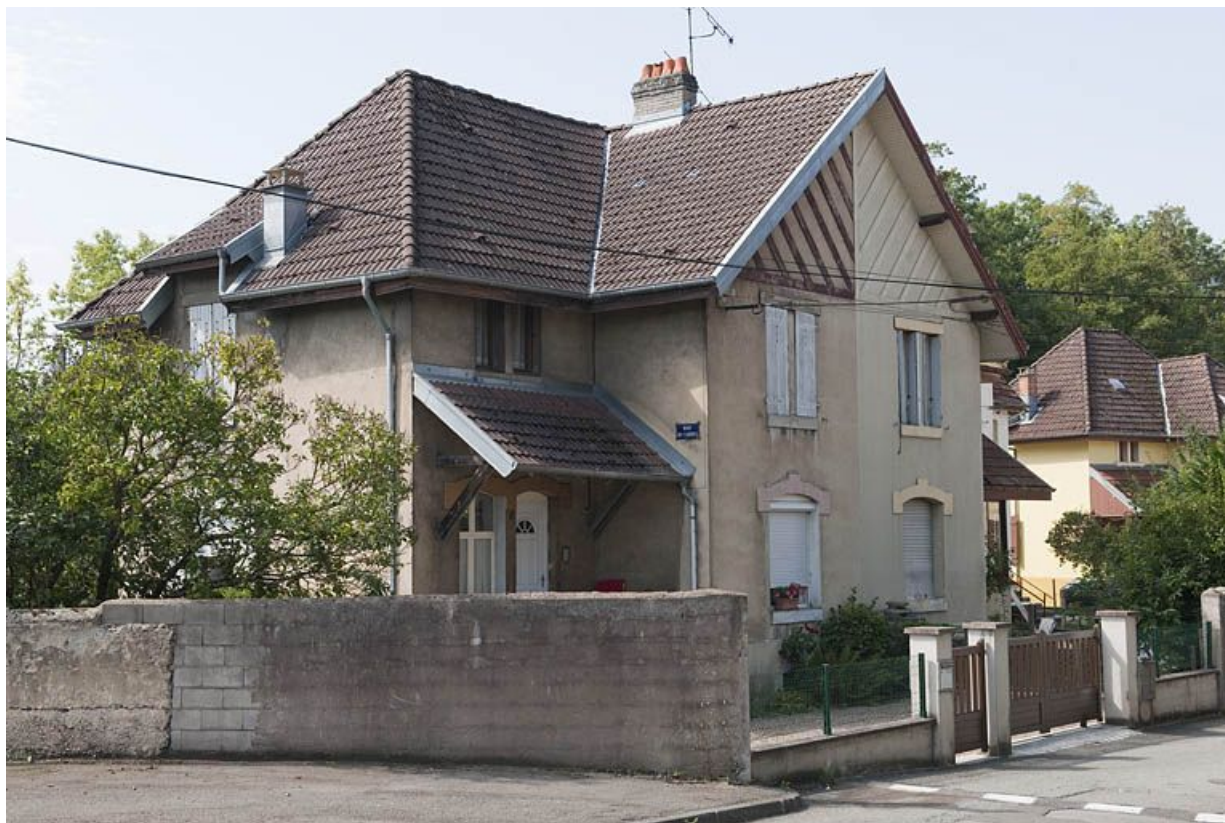
Maison jumelée à l'entrée de la rue de Flandres.
