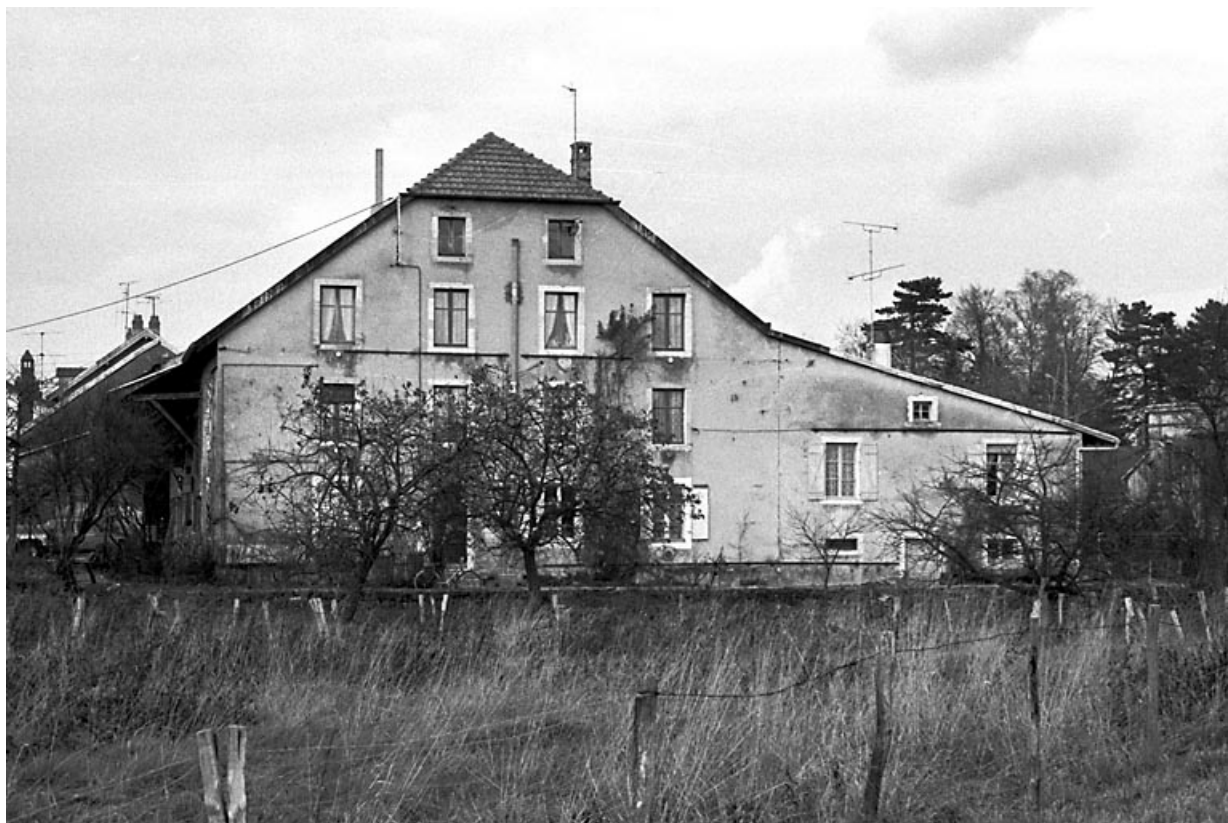
Vue du pignon droit de l'habitation.
