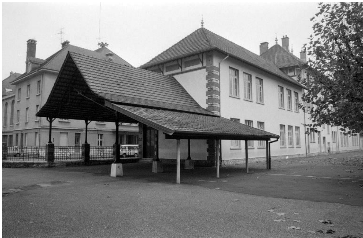
Façade sur cour, de trois quarts gauche.
