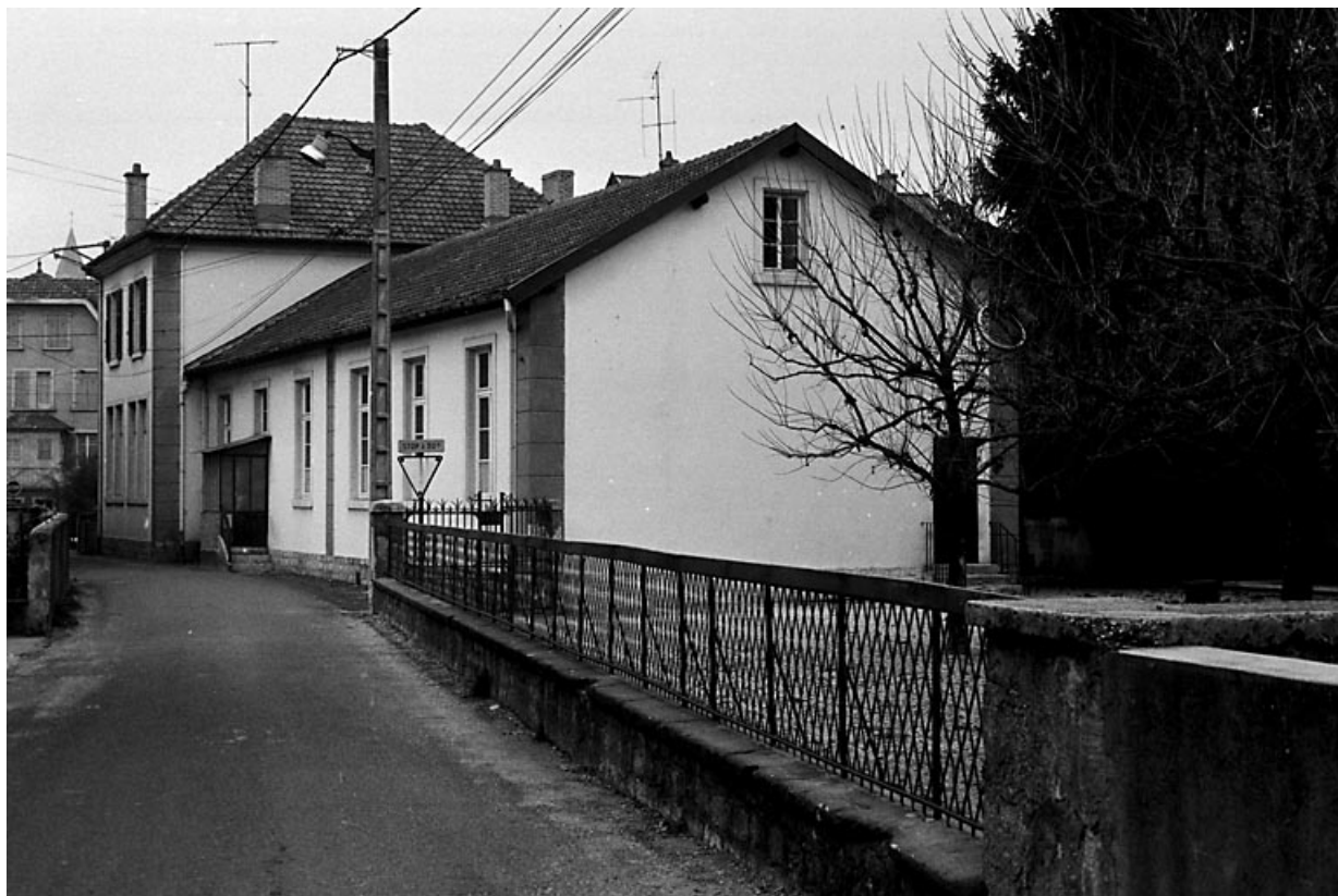
Vue d'ensemble des bâtiments.
