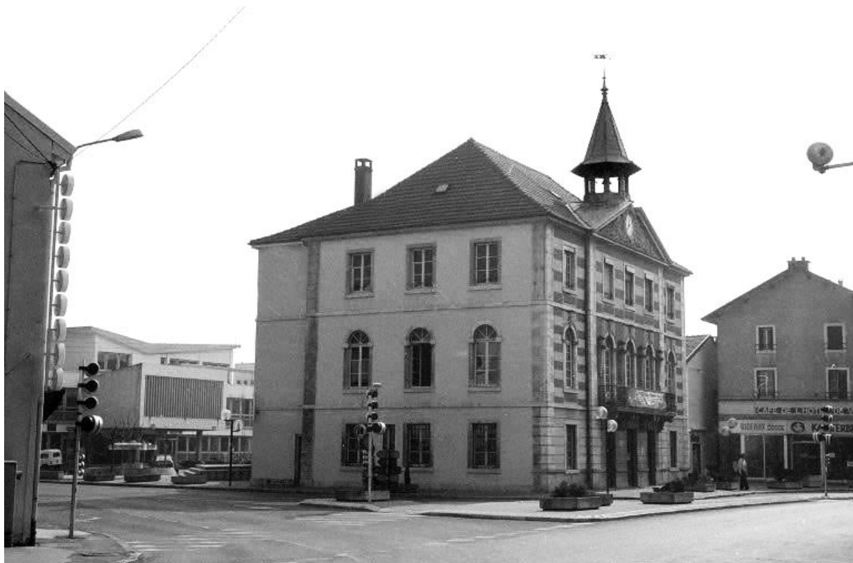
Façades antérieure et latérale droite.
