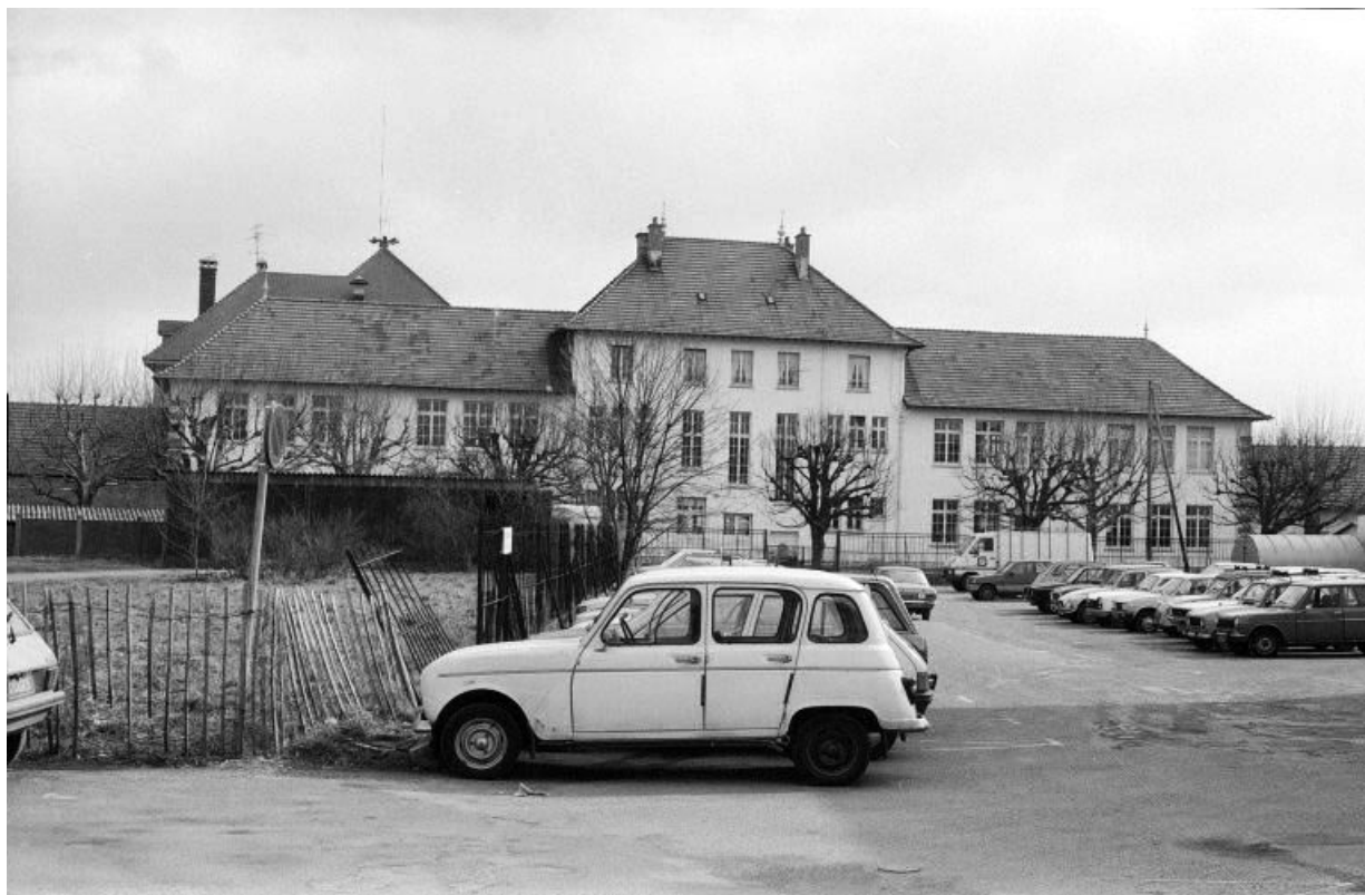
Façade postérieure sur cour. 25, Audincourt
