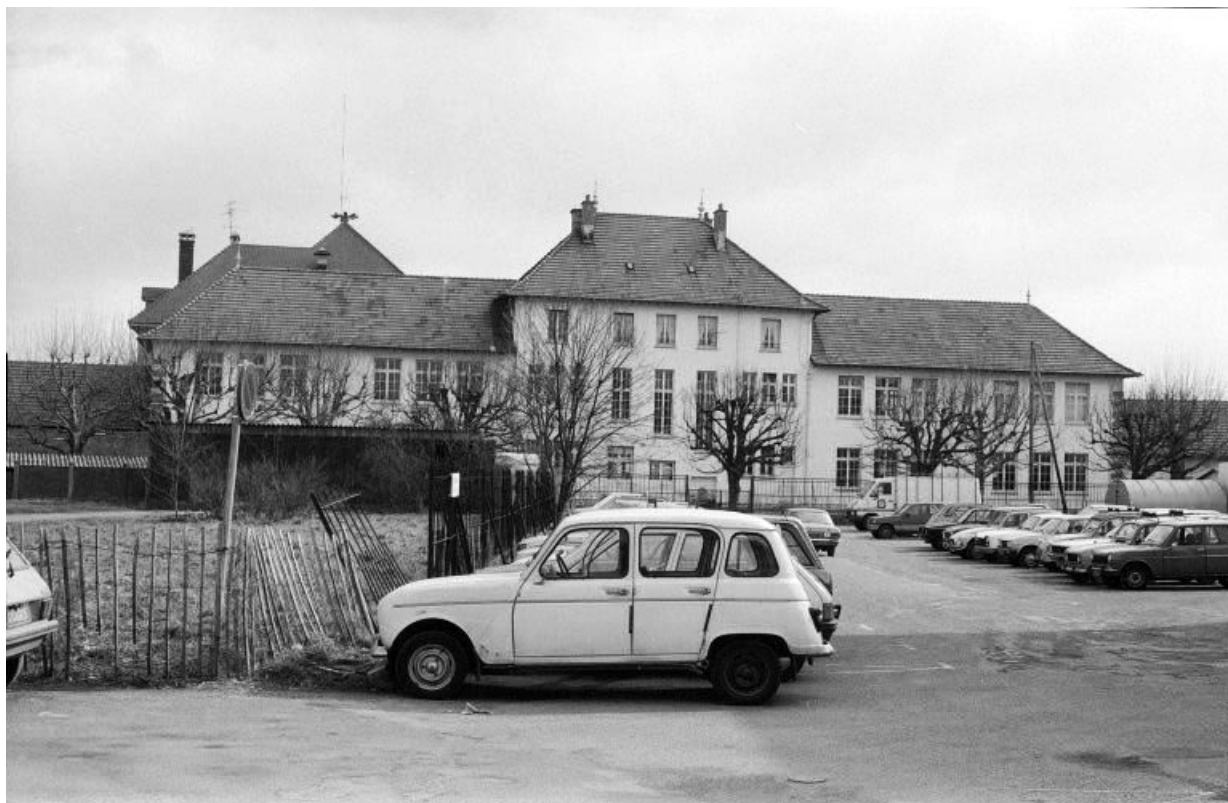
Façade postérieure sur cour.
