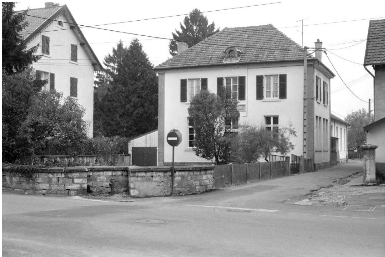
Façades antérieure et latérale droite. 25, Audincourt
