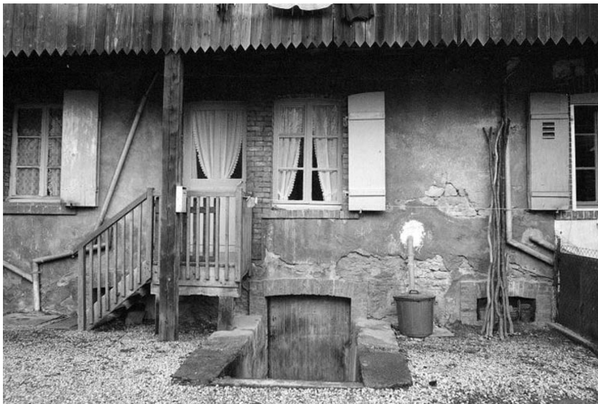
Façade postérieure : détail. 25, Audincourt
