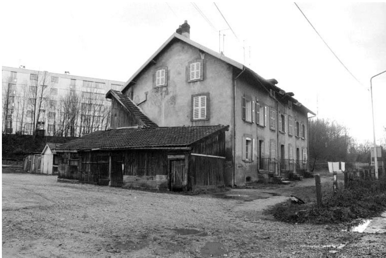
Façades antérieure et latérale gauche. 25, Audincourt, 61 rue de Valentigney
