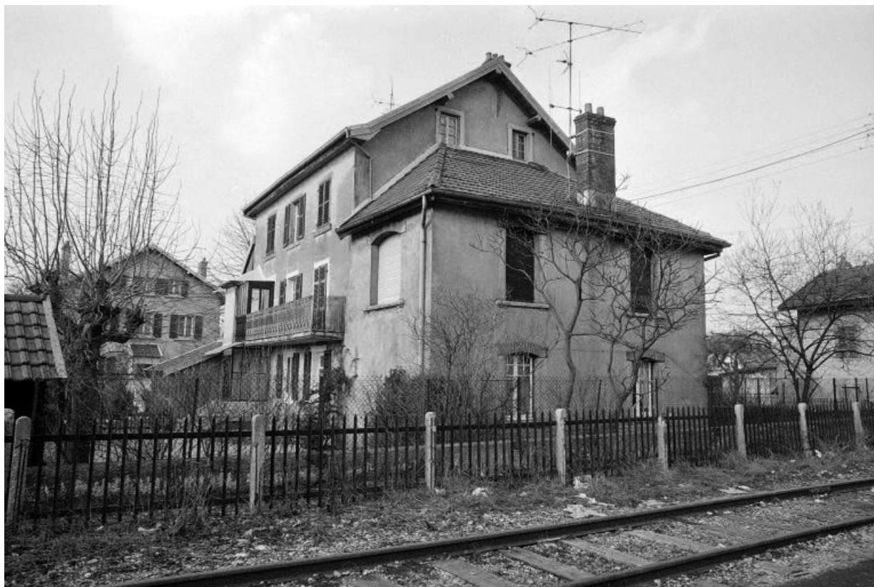
Façades antérieure et latérale gauche. 25, Audincourt, 43 rue de Champagne
