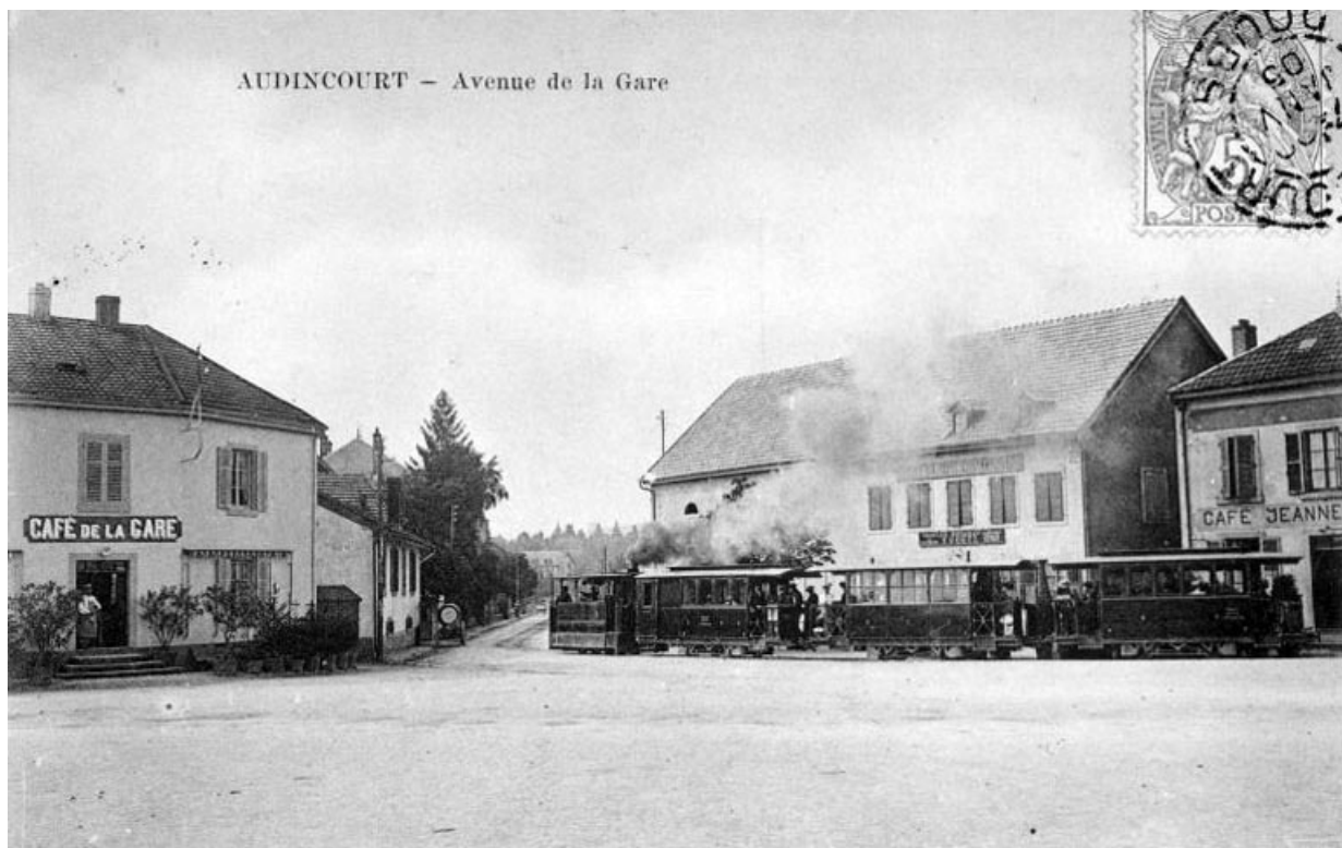
Vue d'ensemble avec le passage d'un train. 25, Audincourt, 3 avenue de la Gare
