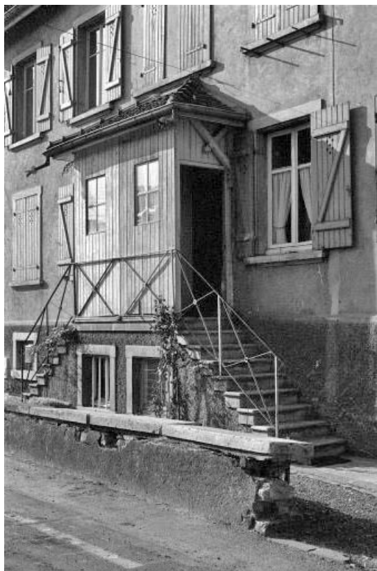
Détail de l'élévation antérieure.
