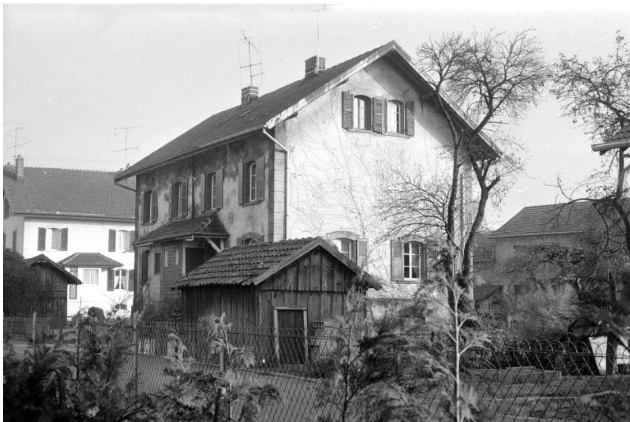
Façades antérieure et latérale droite. 25, Audincourt, 17, 19 rue Jeanne d'Arc
