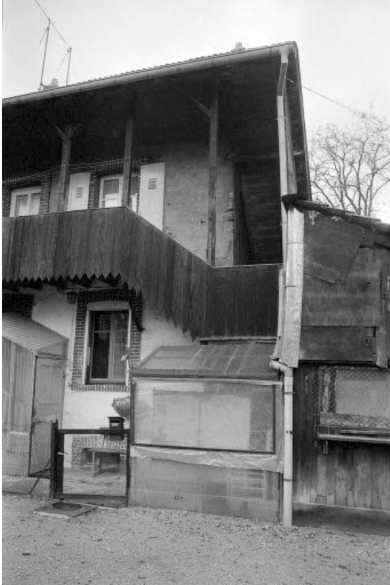
Façade postérieure : détail.
