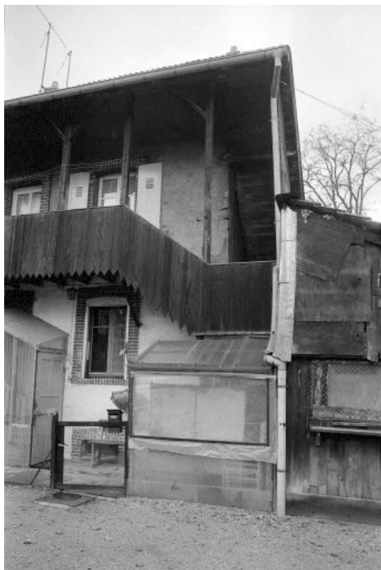
Façade postérieure : détail.
