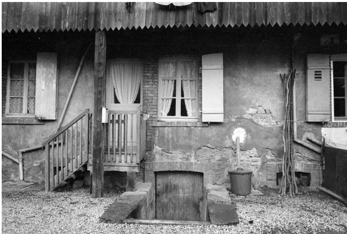
Façade postérieure : détail. 25, Audincourt
