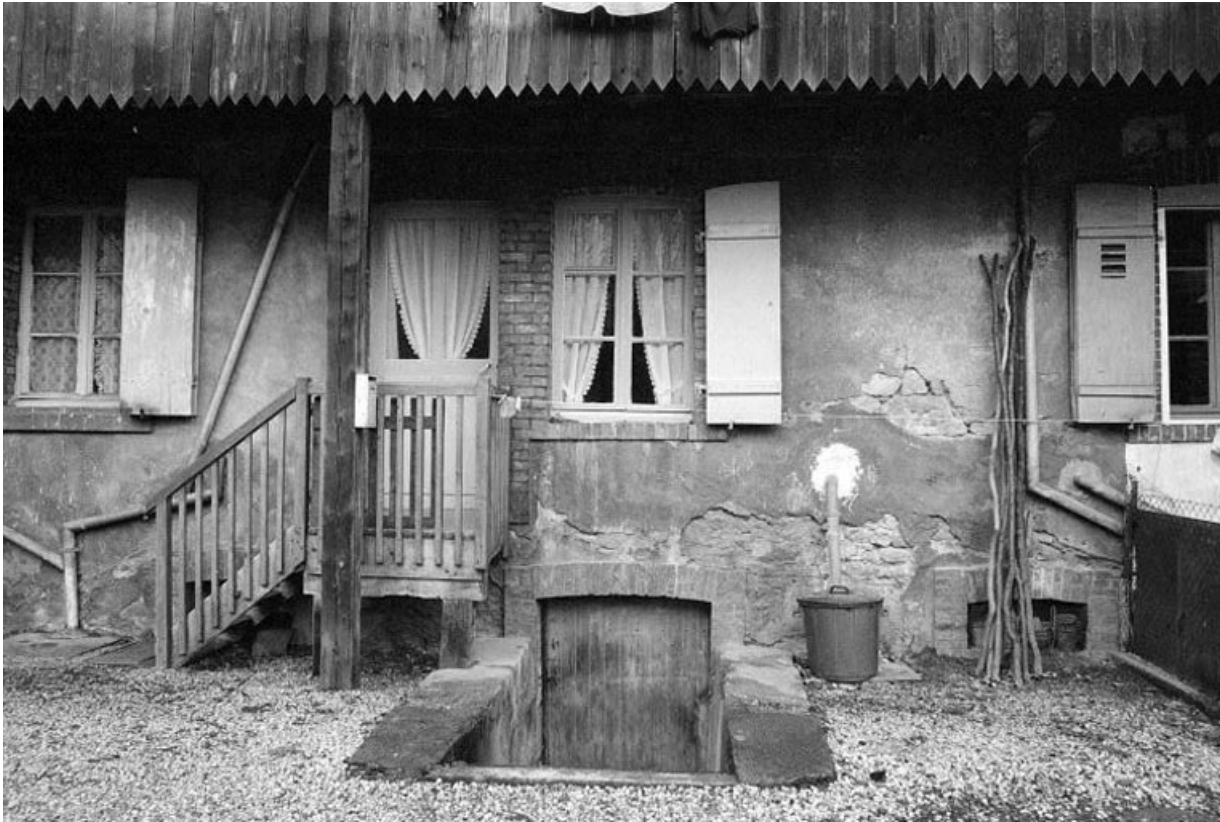
Façade postérieure : détail.
