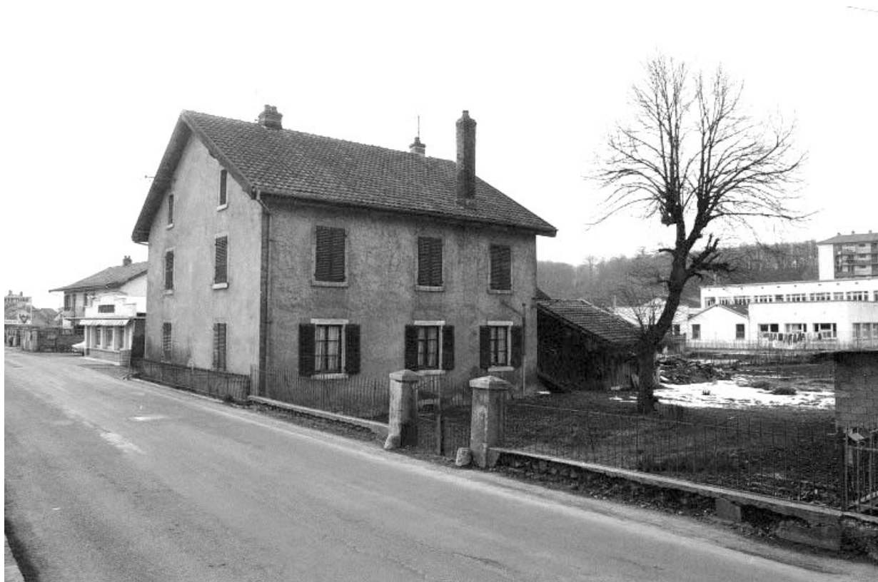
Façades postérieure et latérale droite.
