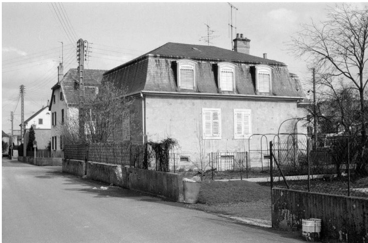
Façades postérieure et latérale droite.
