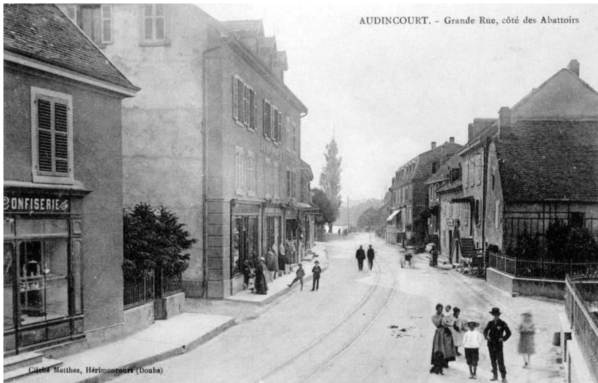
Vue de la Grande Rue, côté des abattoirs 25, Audincourt
