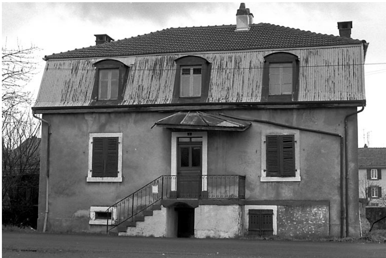
Vue de l'élévation antérieure.
