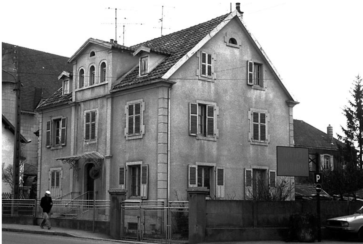
Vue d'ensemble de trois quarts droit. 25, Audincourt Grande Rue 7
