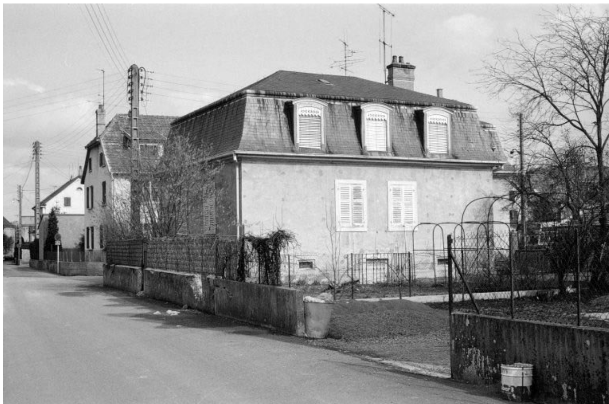
Façades postérieure et latérale droite.
