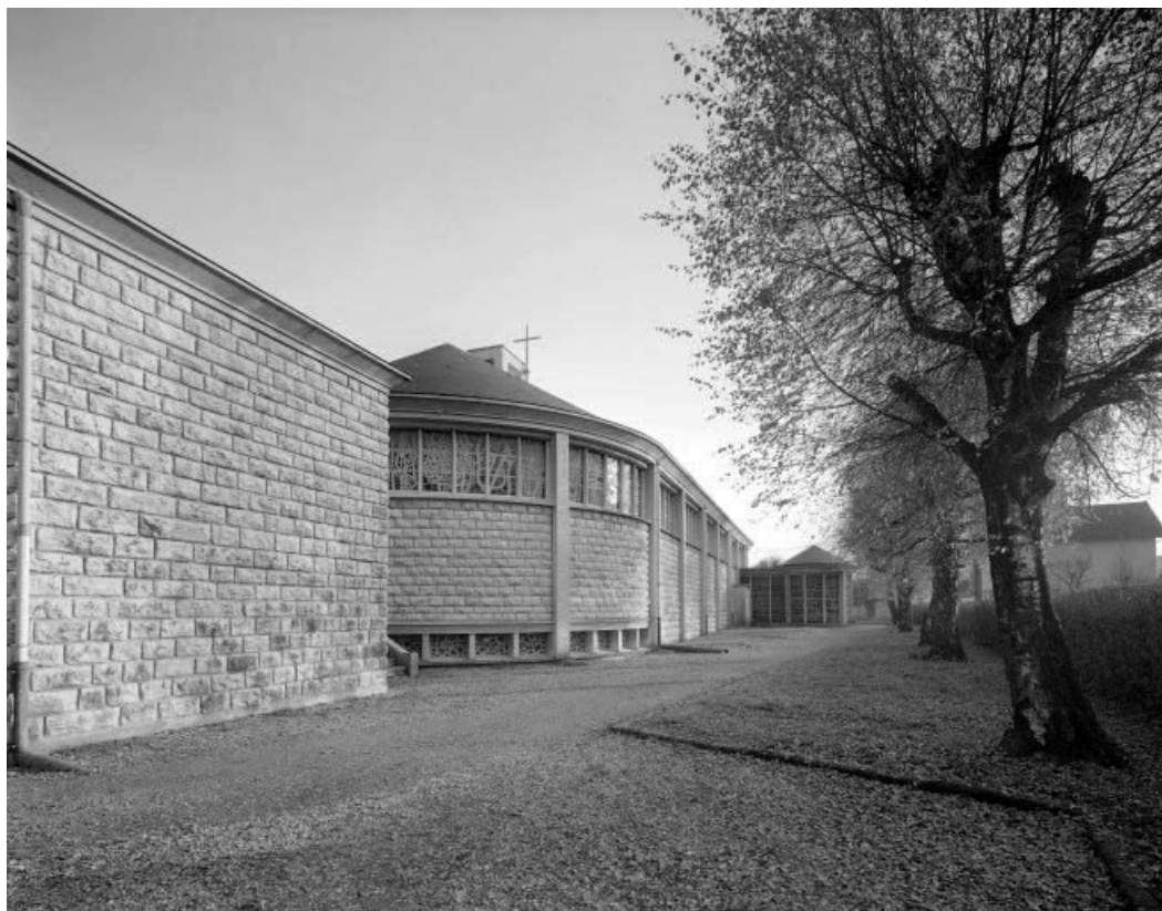
Façade latérale gauche.
