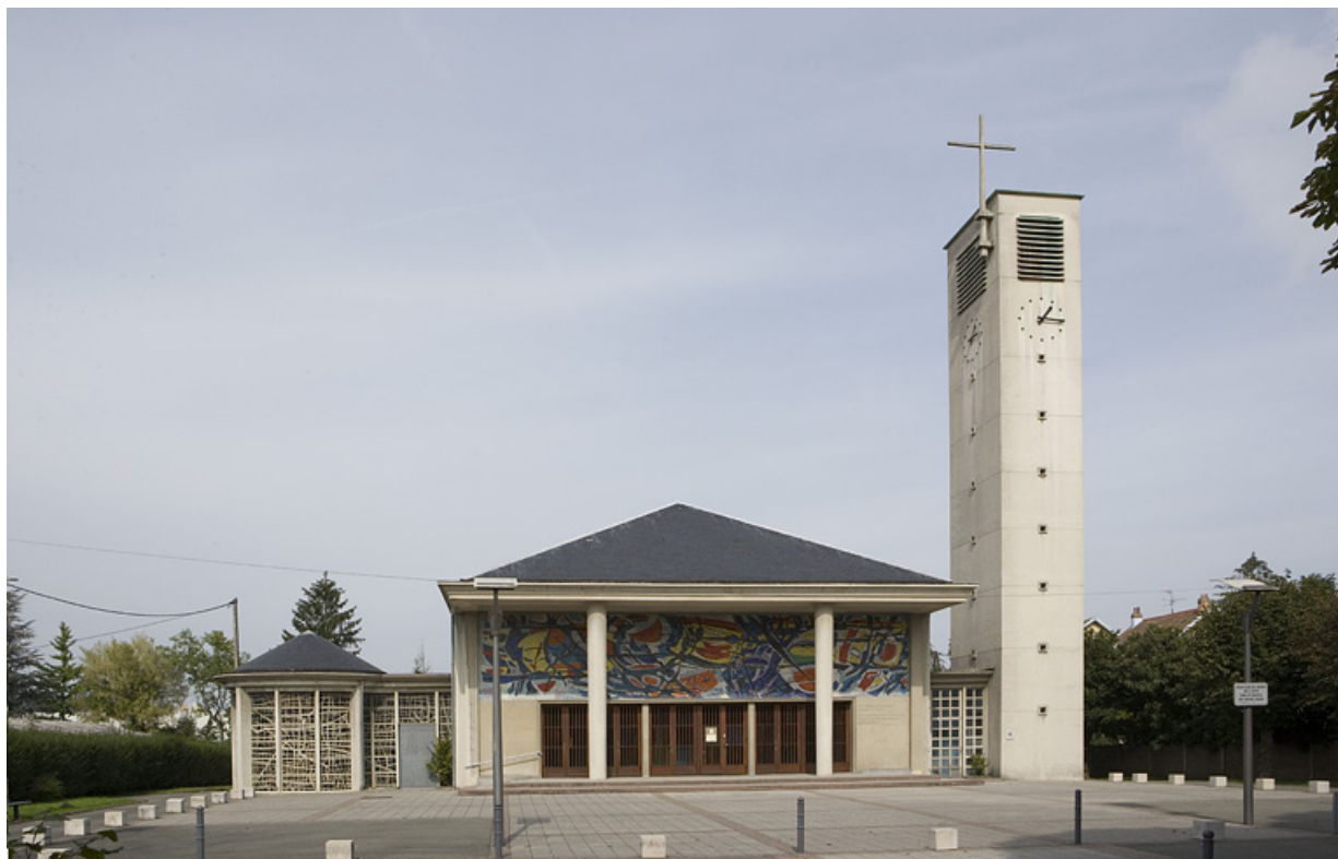
Vue d'ensemble de la façade, mosaïque de Bazaine.
