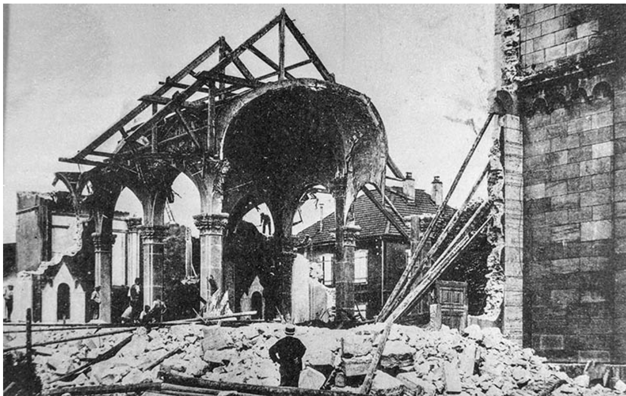
Chantier de construction, 1931. 25, Audincourt, 2 rue du Presbytère
