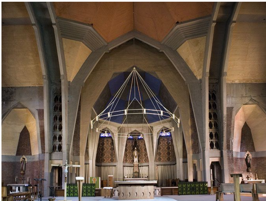
Vue générale de la nef.
