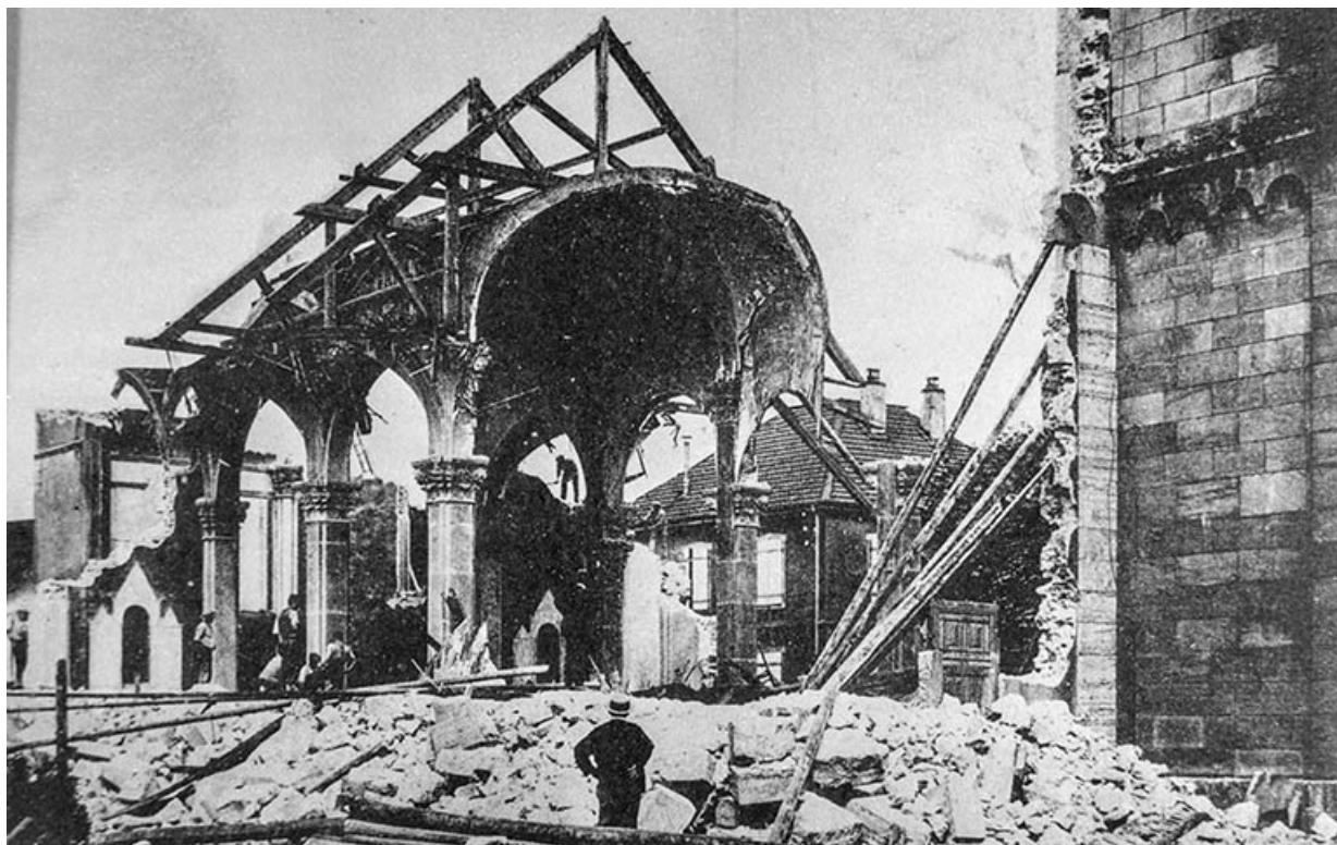
Chantier de construction, 1931. 25, Audincourt, 2 rue du Presbytère
