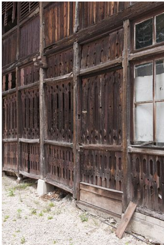
Détail de la façade ouest des communs (remise ou écurie). 25, Audincourt, 72 rue de Valentigney
