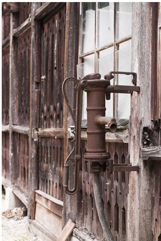
Pompe manuelle contre la façade ouest des communs.
