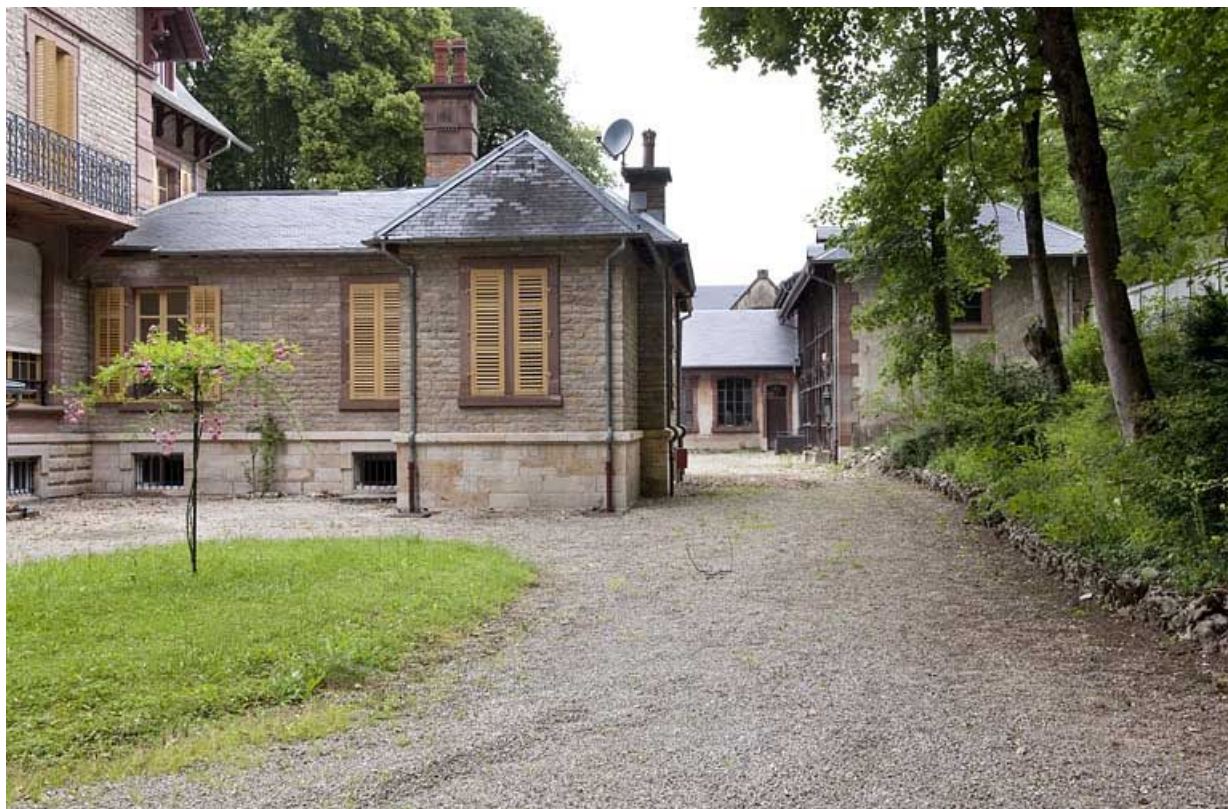
Façade sud de l'annexe et communs.
