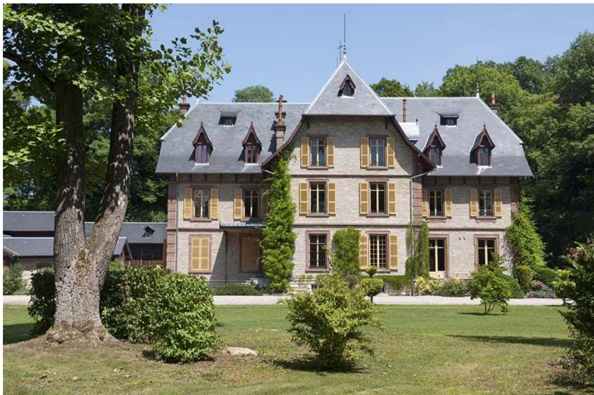
Façade antérieure vue de face.
