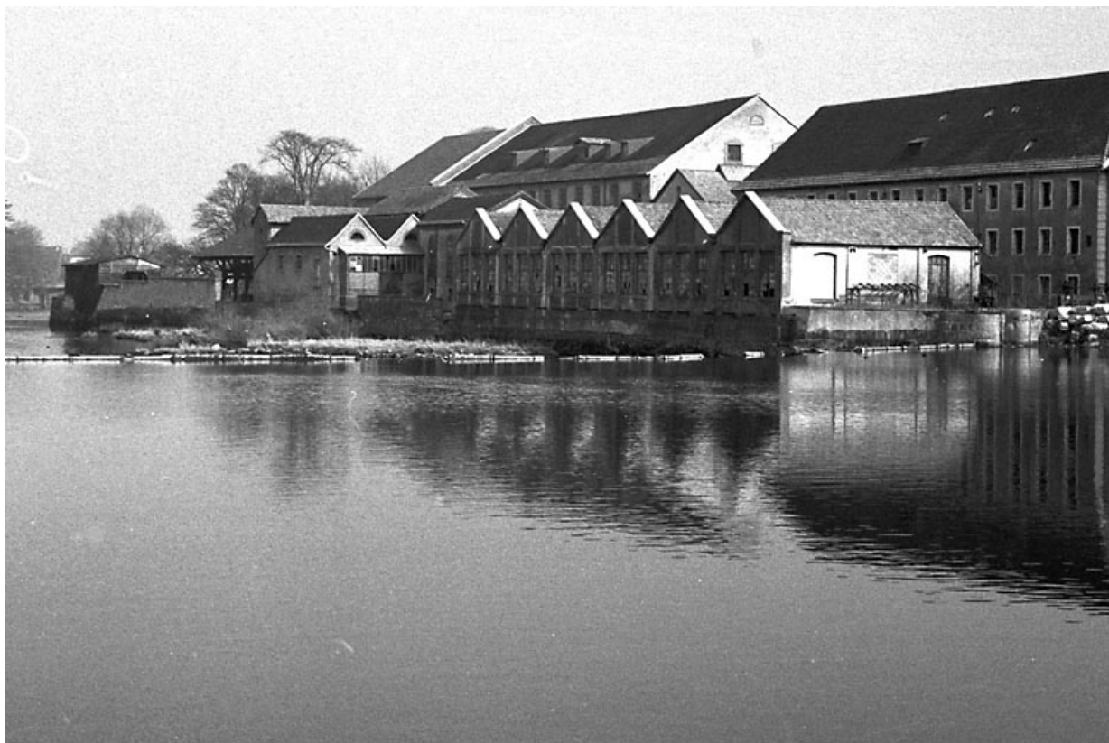
Vue d'ensemble depuis l'amont en 1983.
