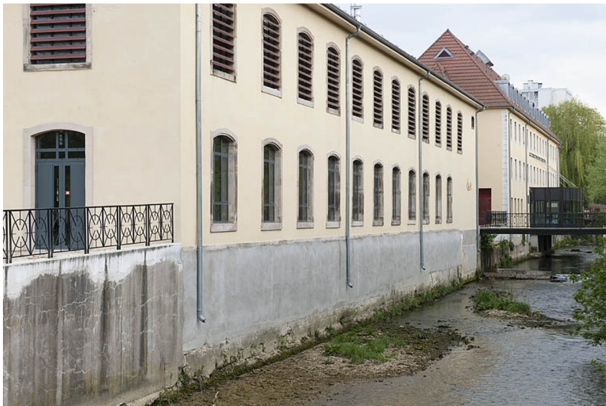
Atelier de filature nord. Façade sur le bief de dérivation.
