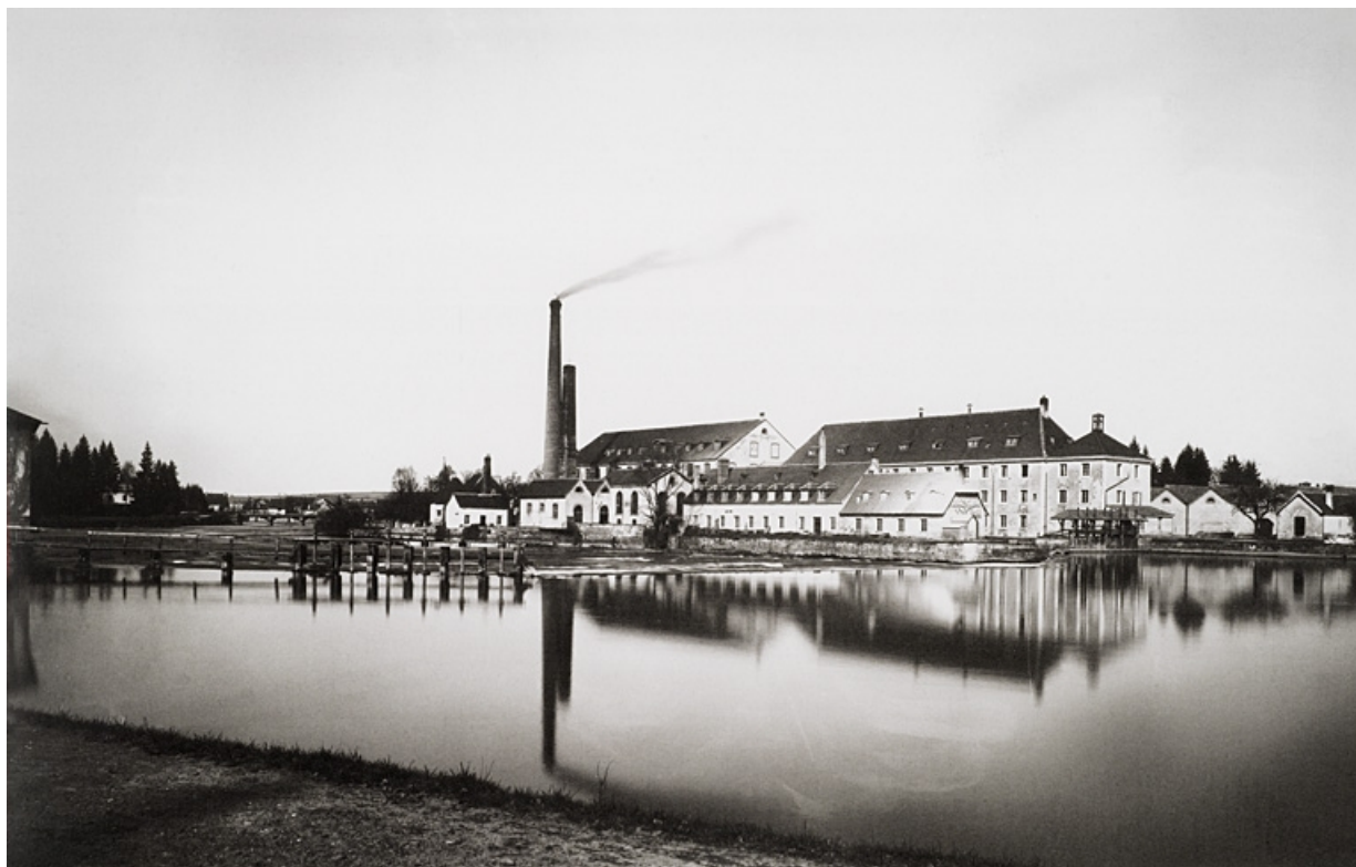
[Vue de la filature depuis le sud-est].
