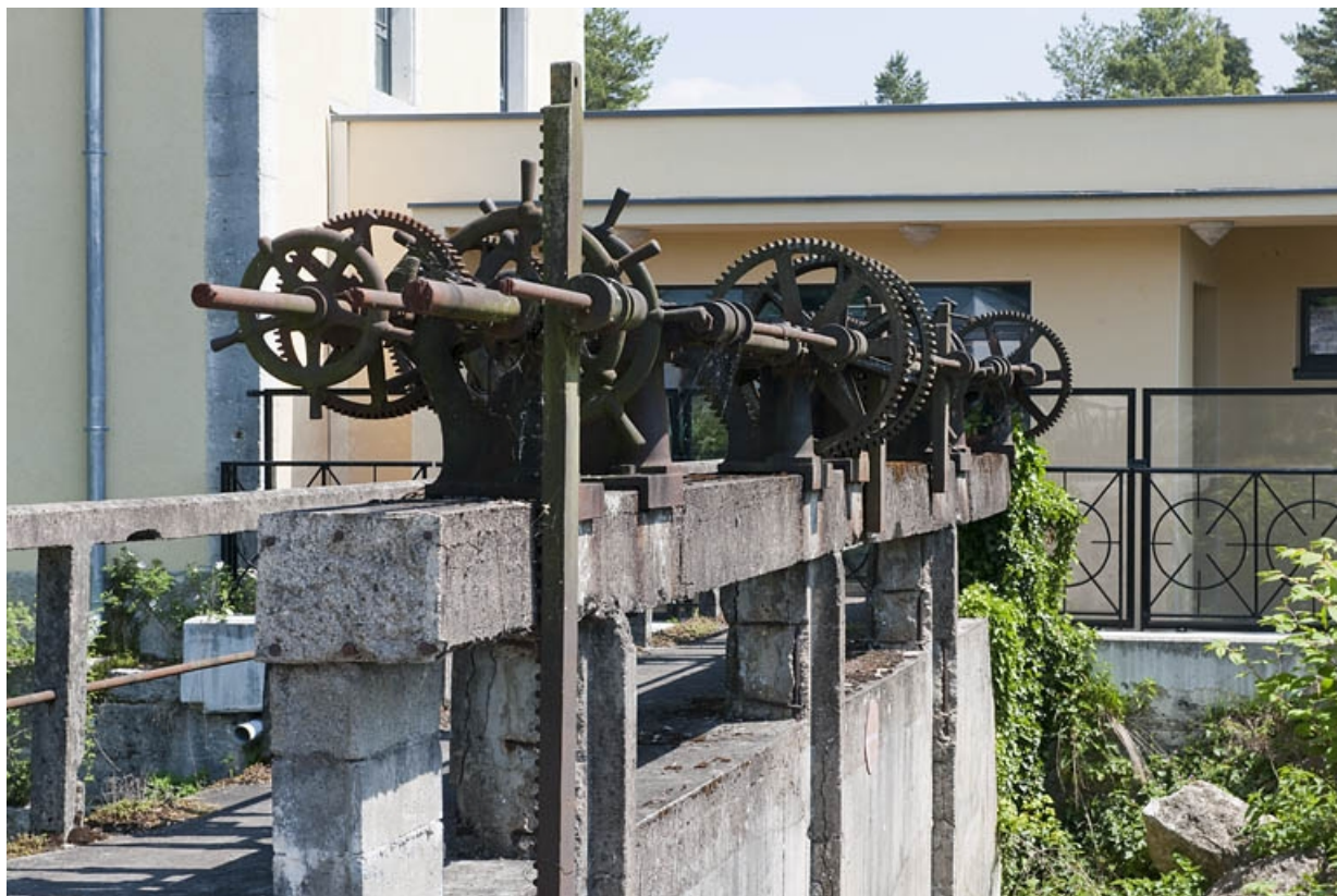
Système de vannage du bief de dérivation. Mécanisme de contrôle. 25, Audincourt allée de la Filature
