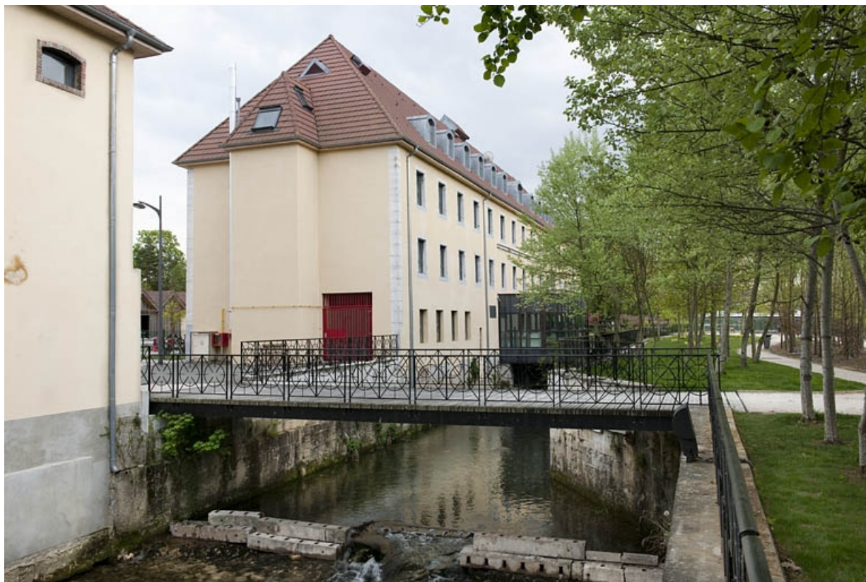
Atelier de filature sud. Façade sur le bief de dérivation.
