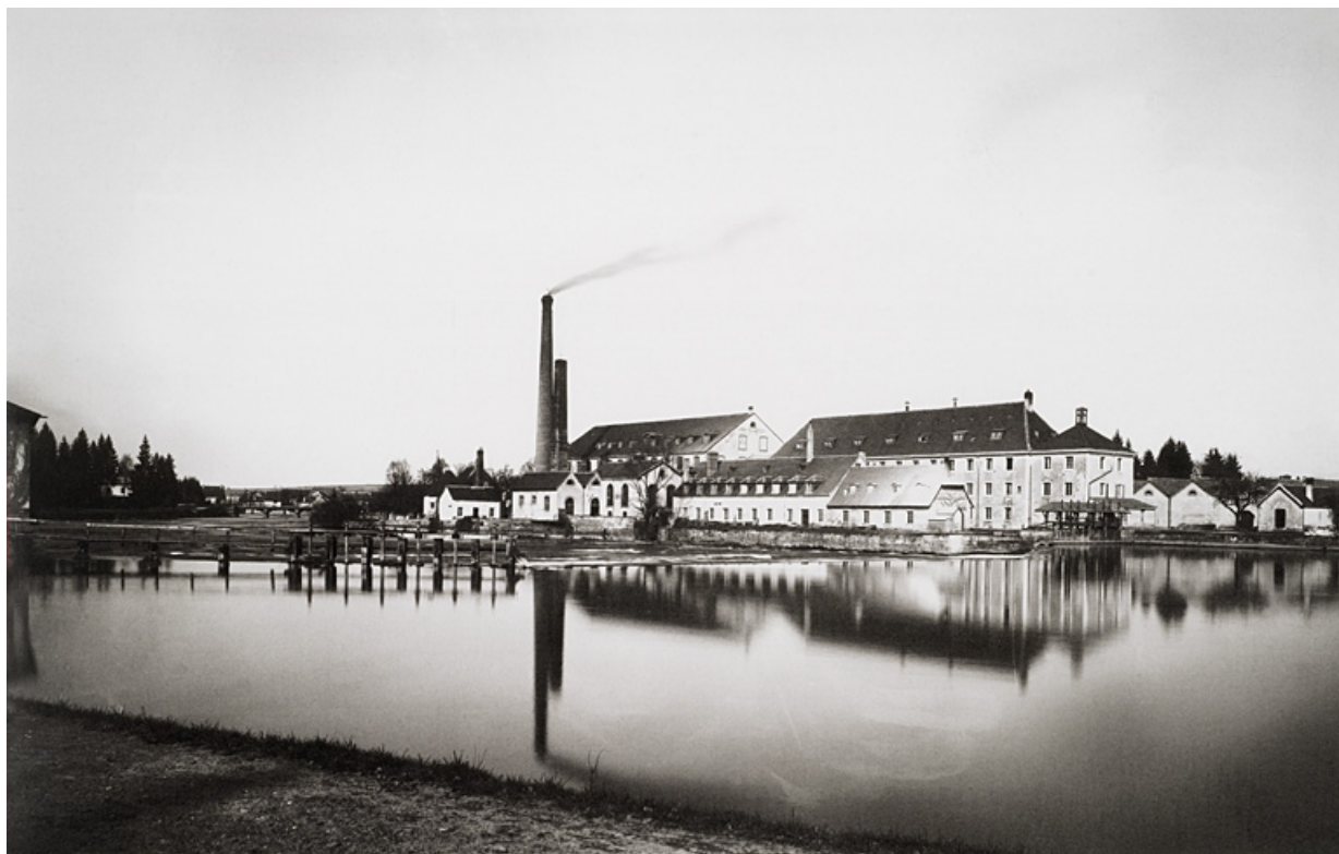
[Vue de la filature depuis le sud-est].
