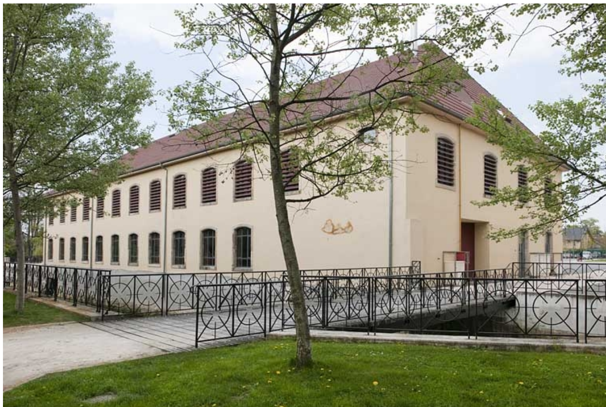
Vue de trois quarts de l'atelier de filature nord.
