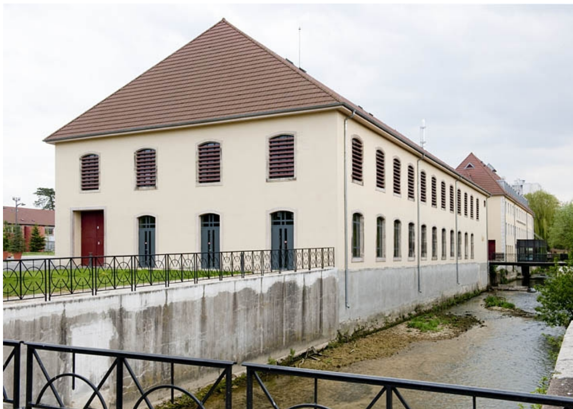
Atelier de filature nord depuis l'aval.
