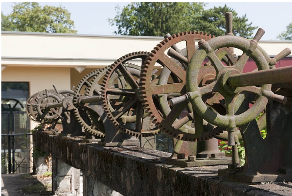
Système de vannage du bief de dérivation. Volants et engrenages.
