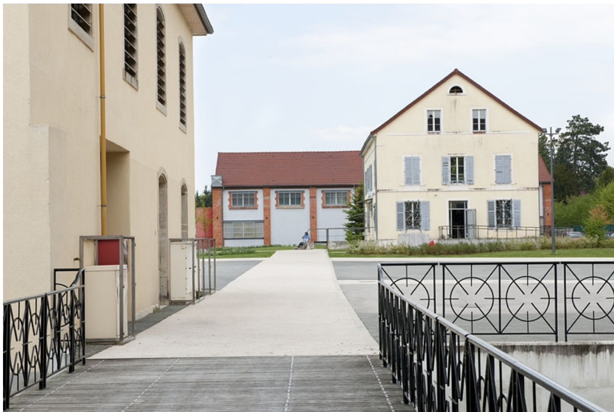
Bureaux et entrepôt industriel depuis l'ouest. 25, Audincourt allée de la Filature
