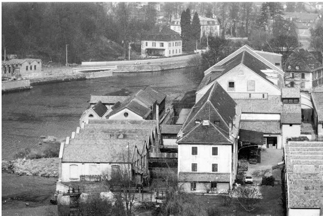
Vue plongeante depuis le sud en 1983.
