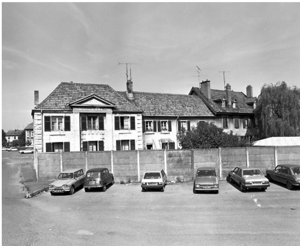
Façade antérieure, cour de l'orangerie.
