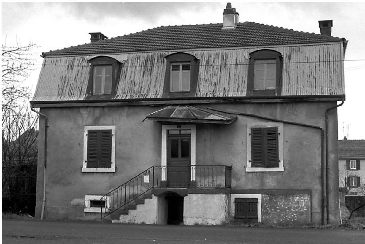
Vue de l'élévation antérieure.
