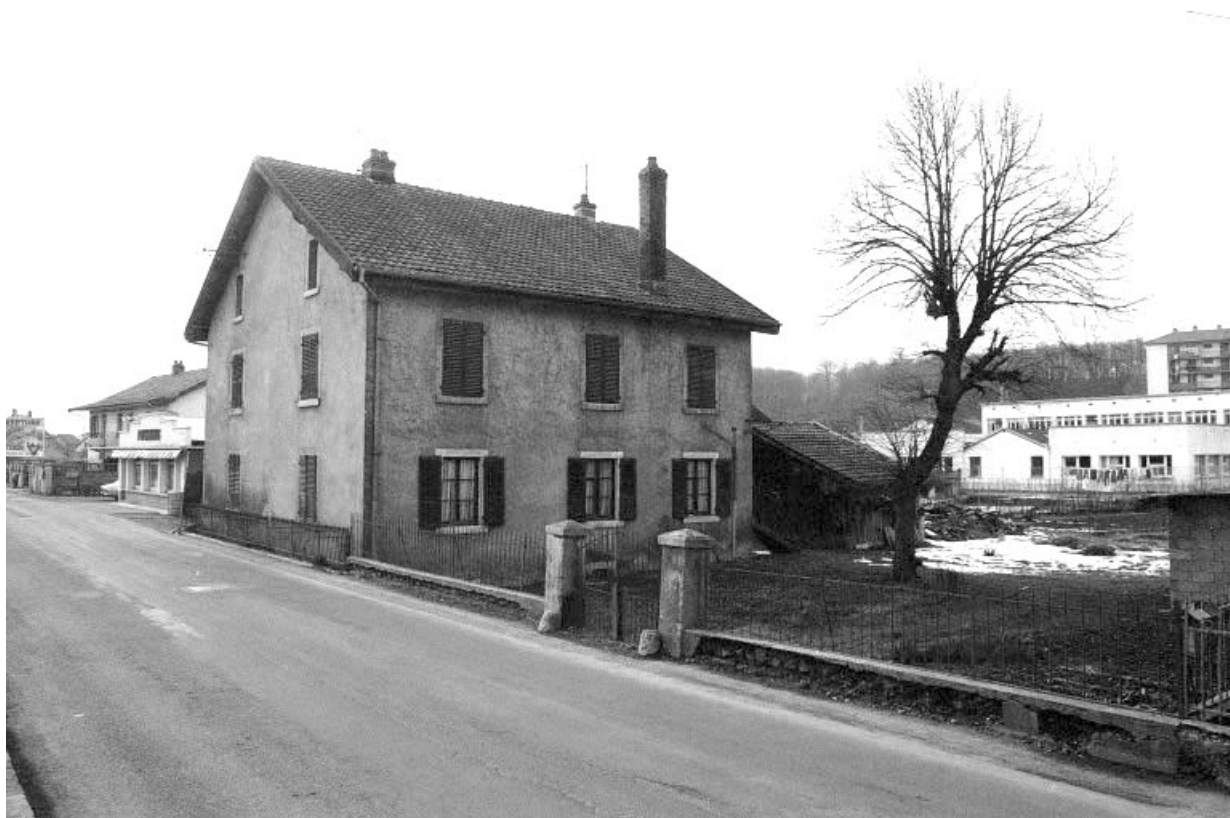
Façades postérieure et latérale droite.
