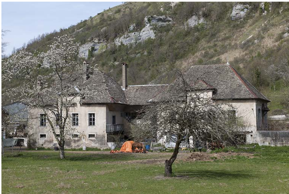
Façade sud du bâtiment abritant les bureaux, logements, écuries et remises. 25, Vuillafans, lieudit : Hauterive
