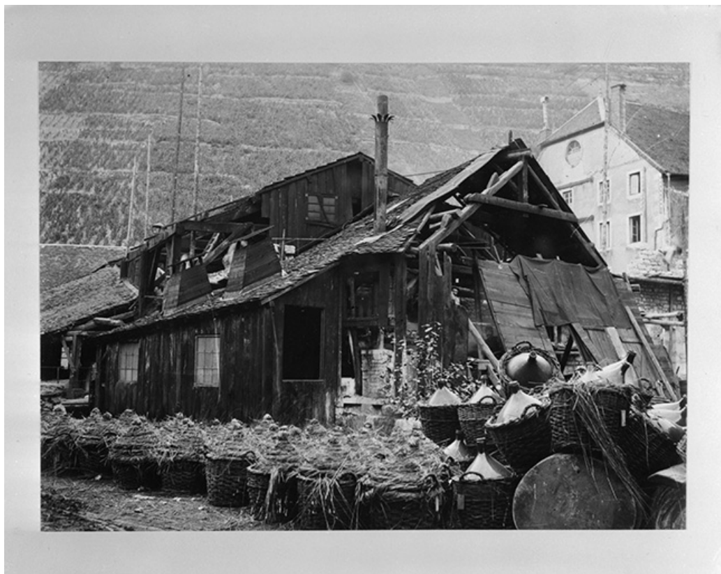
L'atelier dit "la décaperie" et le stock d'acide chlorhydrique, vers 1903. 25, Vuillafans, lieudit : Hauterive
