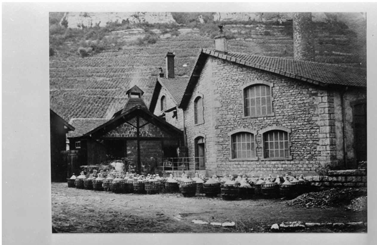
L'atelier dit "la décaperie", peu après l'incendie de 1903. 25, Vuillafans, lieudit : Hauterive
