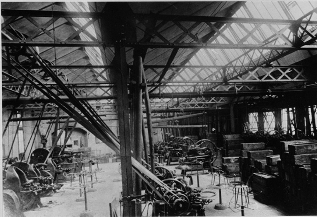
Intérieur de la clouterie : les tourets et les machines à clous, vers 1890-1900.
