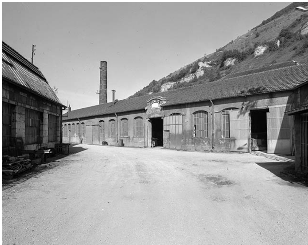
Façade antérieure de la clouterie.
