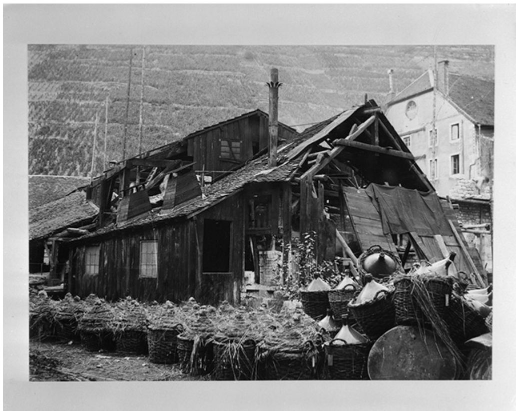
L'atelier dit "la décaperie" et le stock d'acide chlorhydrique, vers 1903. 25, Vuillafans, lieudit : Hauterive
