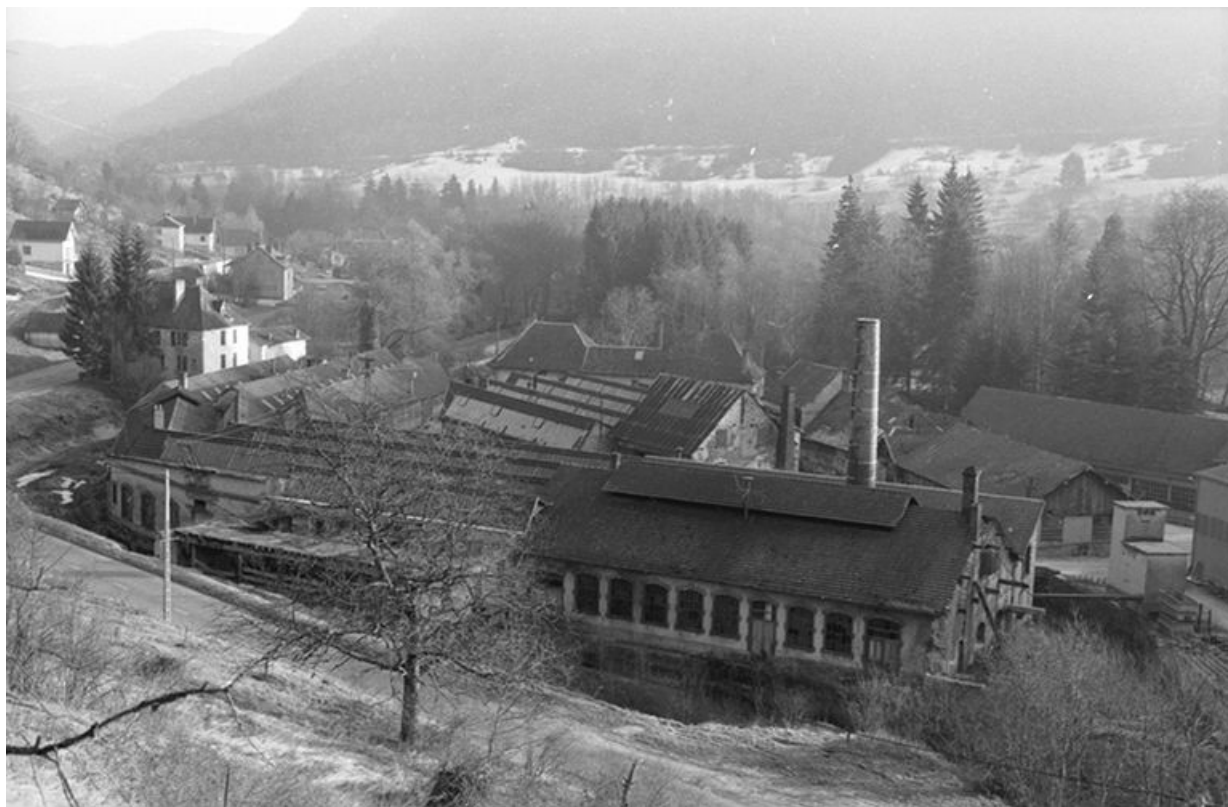
Vue d'ensemble des bâtiments de la clouterie d'Hauterive.
