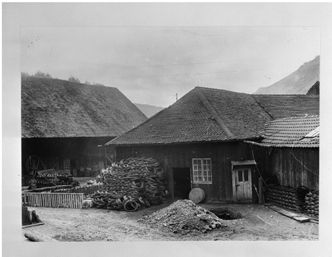
Entrepôt où les rouleaux de fil de fer étaient stockés, avant l'incendie de 1903.
