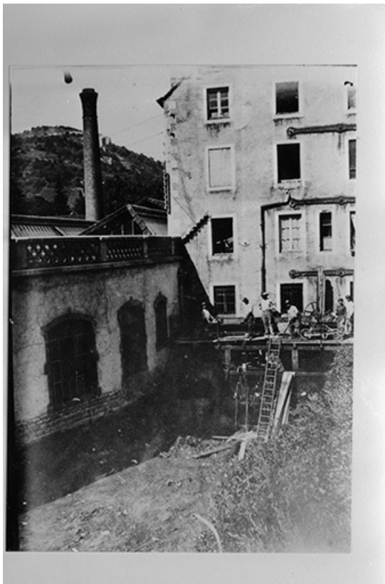
Opération de curage du canal de dérivation, après 1903. 25, Vuillafans, lieudit : Hauterive
