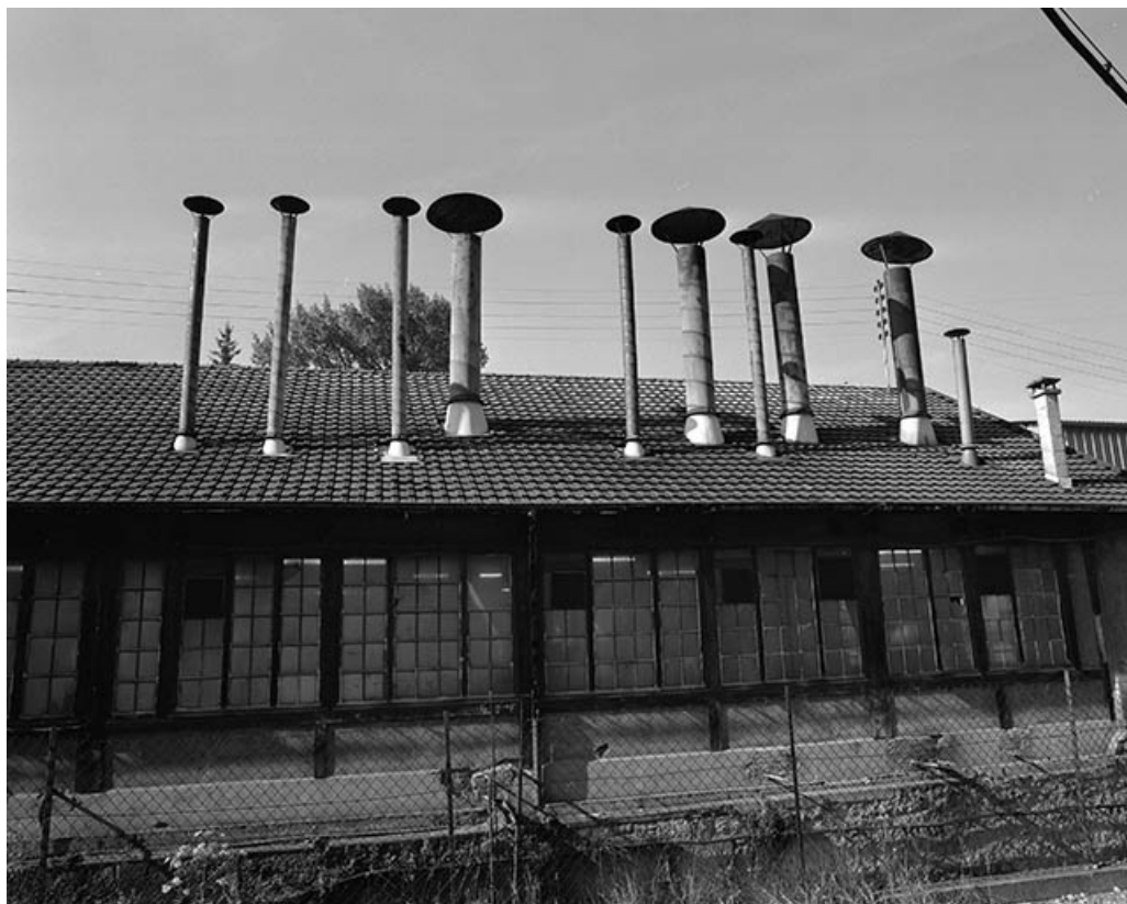
L'atelier de fabrication des pompes à bras (avant 1951), puis atelier de peinture de la Société des Usines de Vuillafans. 25, Vuillafans, lieudit : Hauterive
