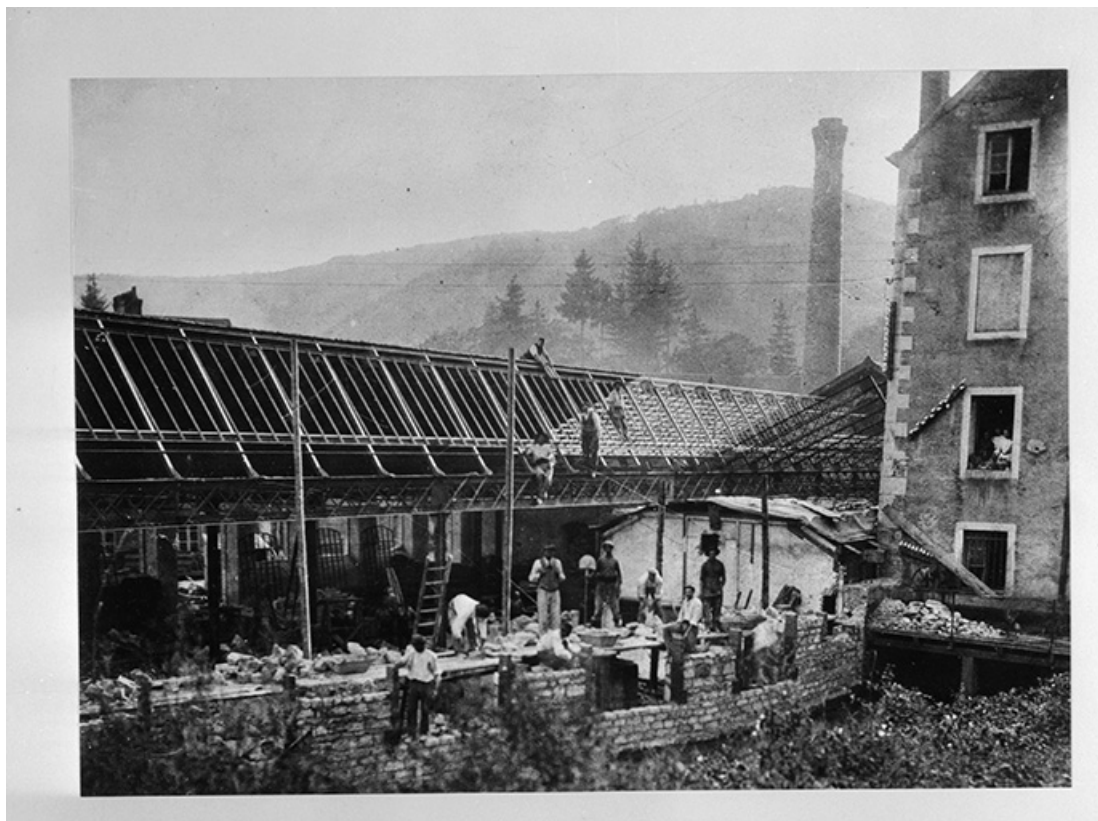
La clouterie en cours de construction, après l'incendie de 1903.
