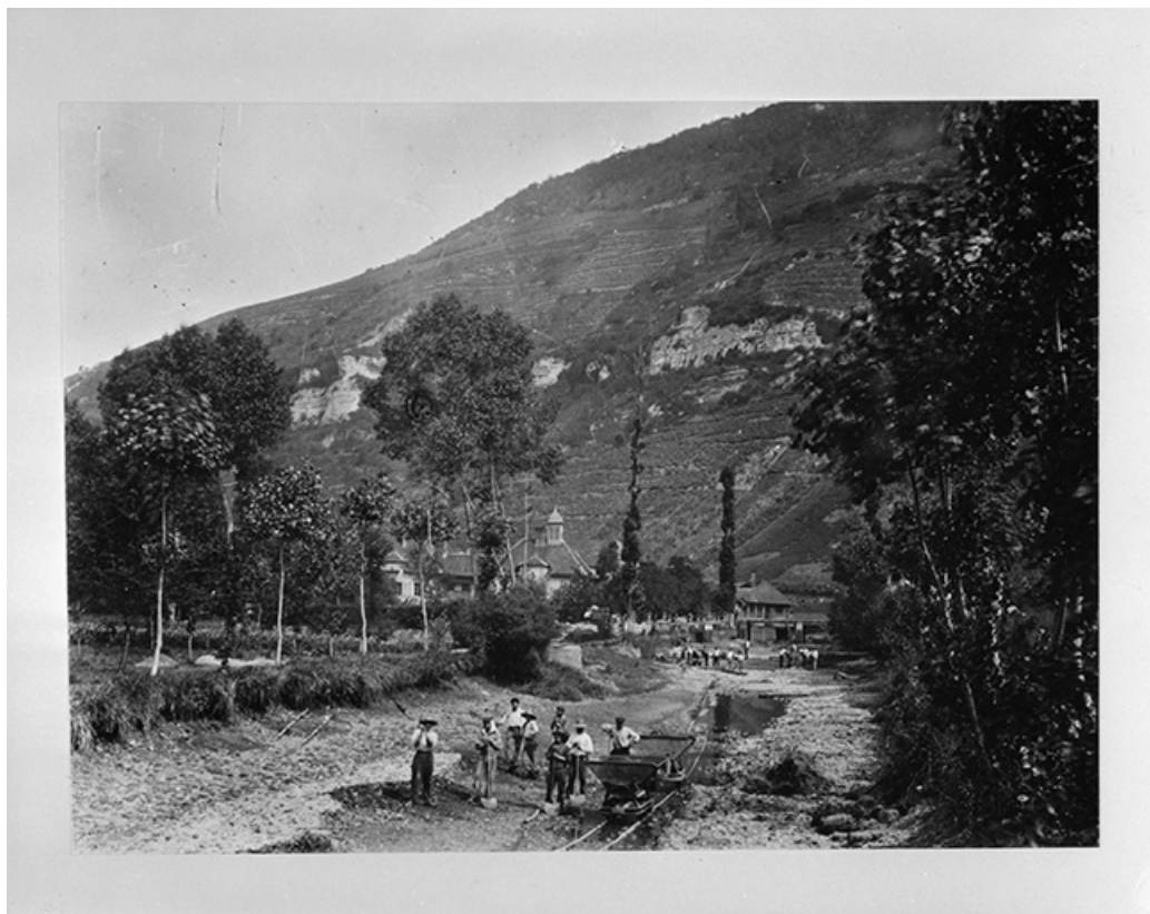
Opération de curage du canal de dérivation en amont d'Hauterive, après 1903. 25, Vuillafans, lieudit : Hauterive
