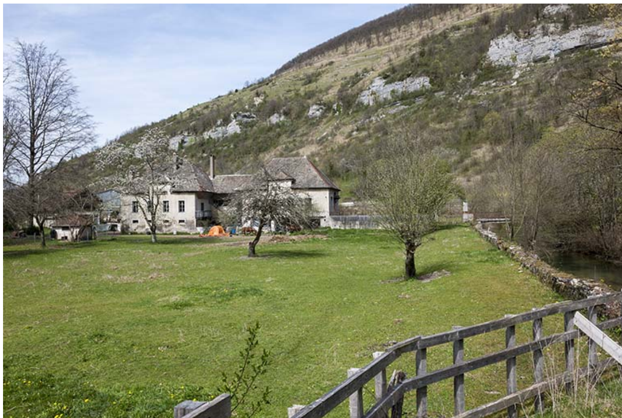
Vue d'ensemble depuis le sud.
