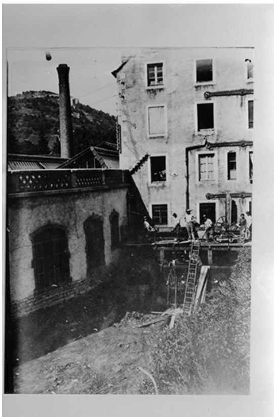
Opération de curage du canal de dérivation, après 1903.
