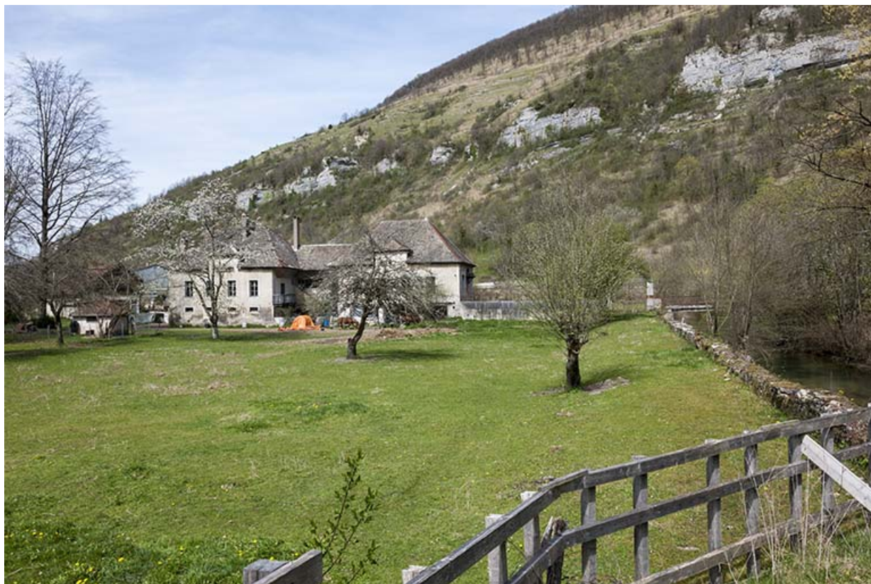
Vue d'ensemble depuis le sud.
