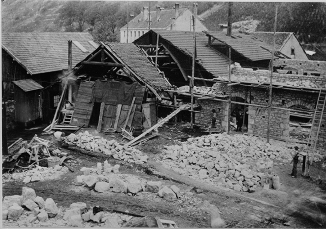
L' atelier dit " la décaperie" en cours de reconstruction, après l'incendie de 1903. 25, Vuillafans, lieudit : Hauterive
