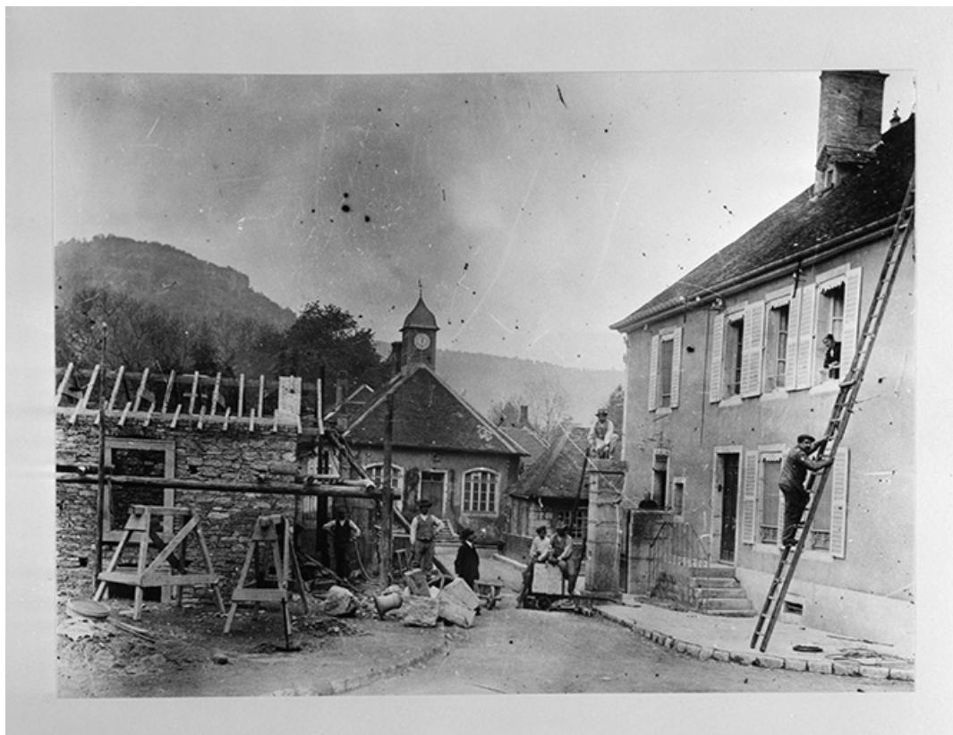
Construction de la conciergerie, vers 1930.
