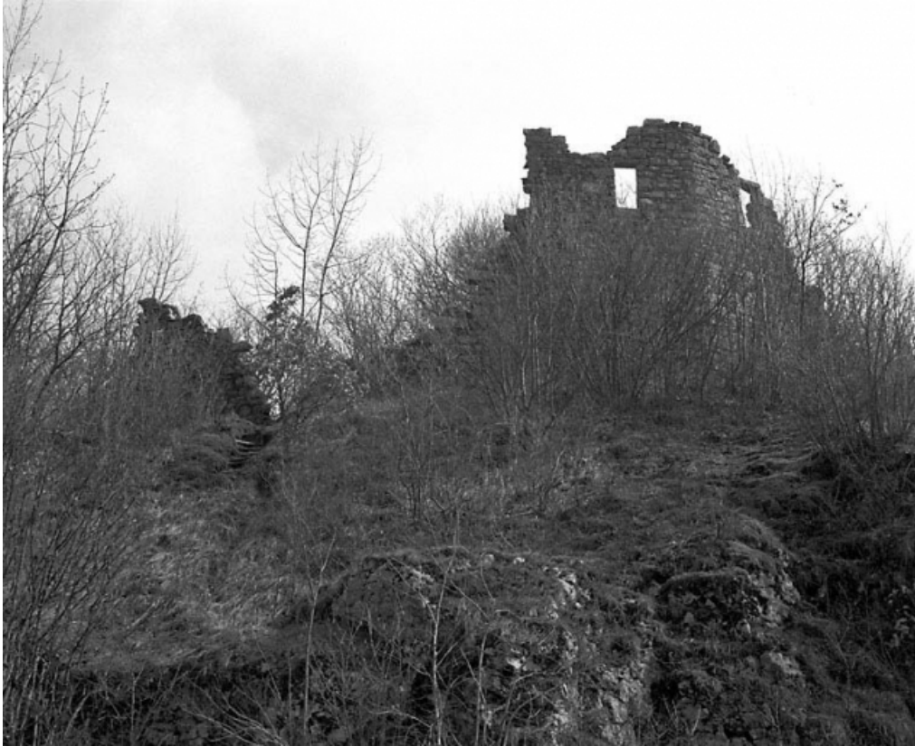
Élévation du côté de la vallée.
