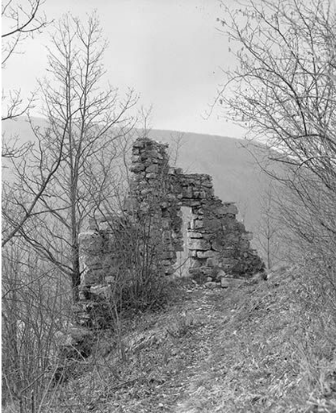
Détail : face interne de l'enceinte.
