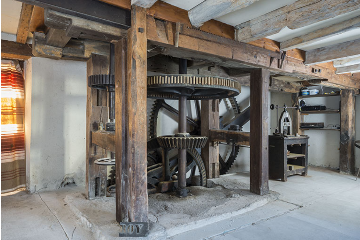
Rez-de-chaussée : beffroi (ouest) des meules.
