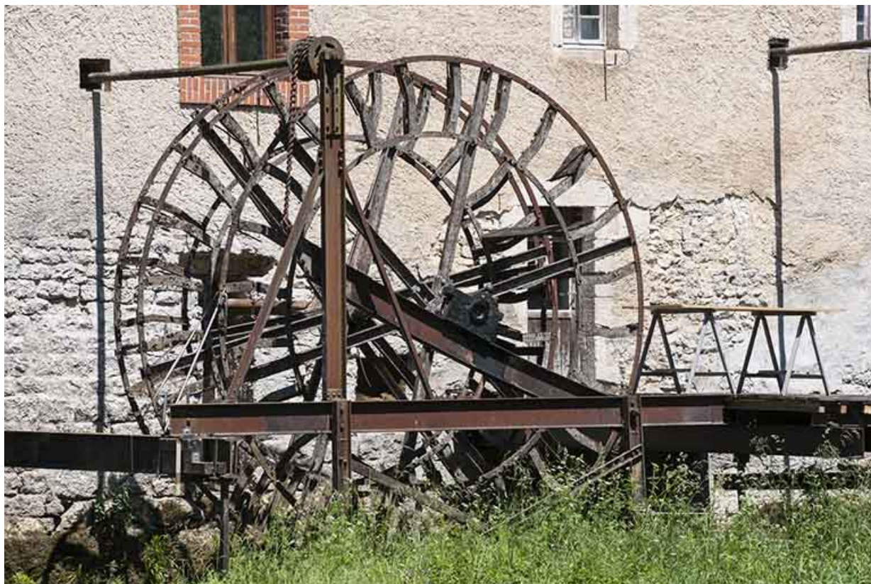
Roue hydraulique aval depuis la rive droite.
