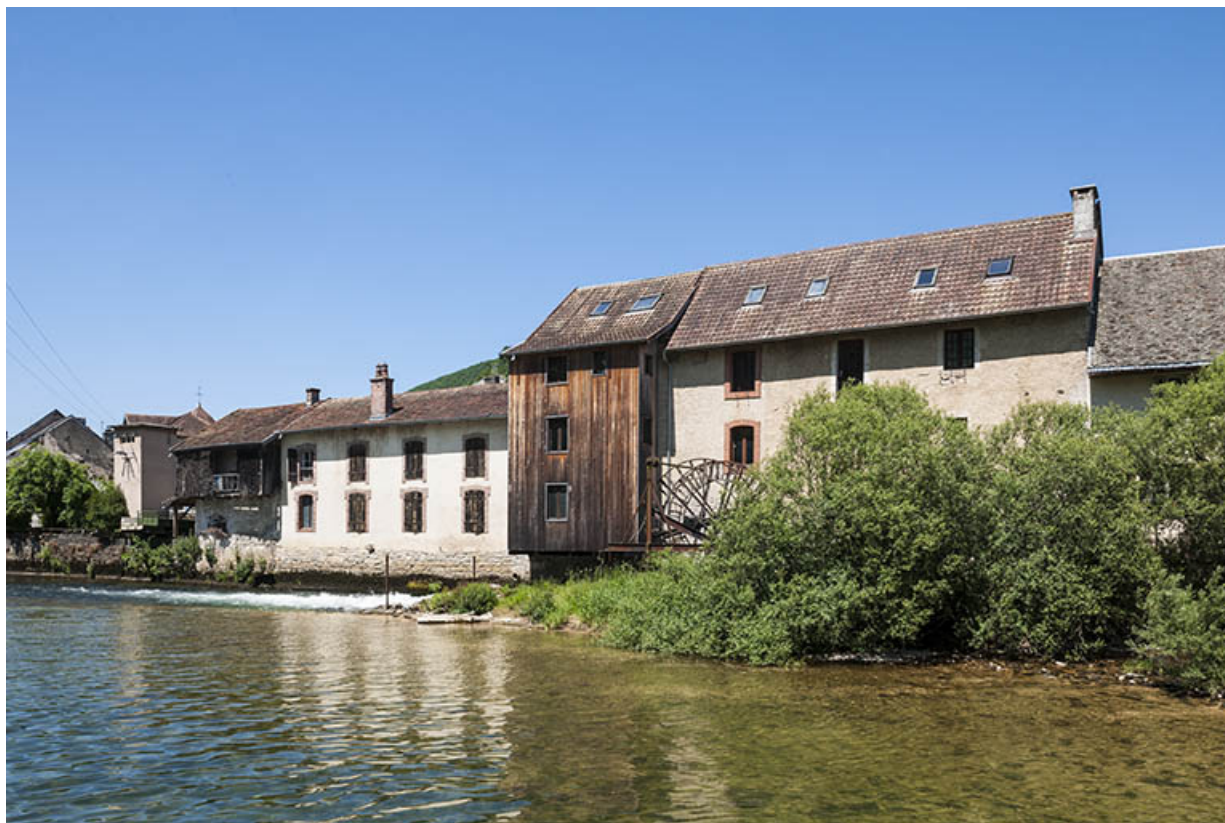
Vue d'ensemble depuis la rive droite.
