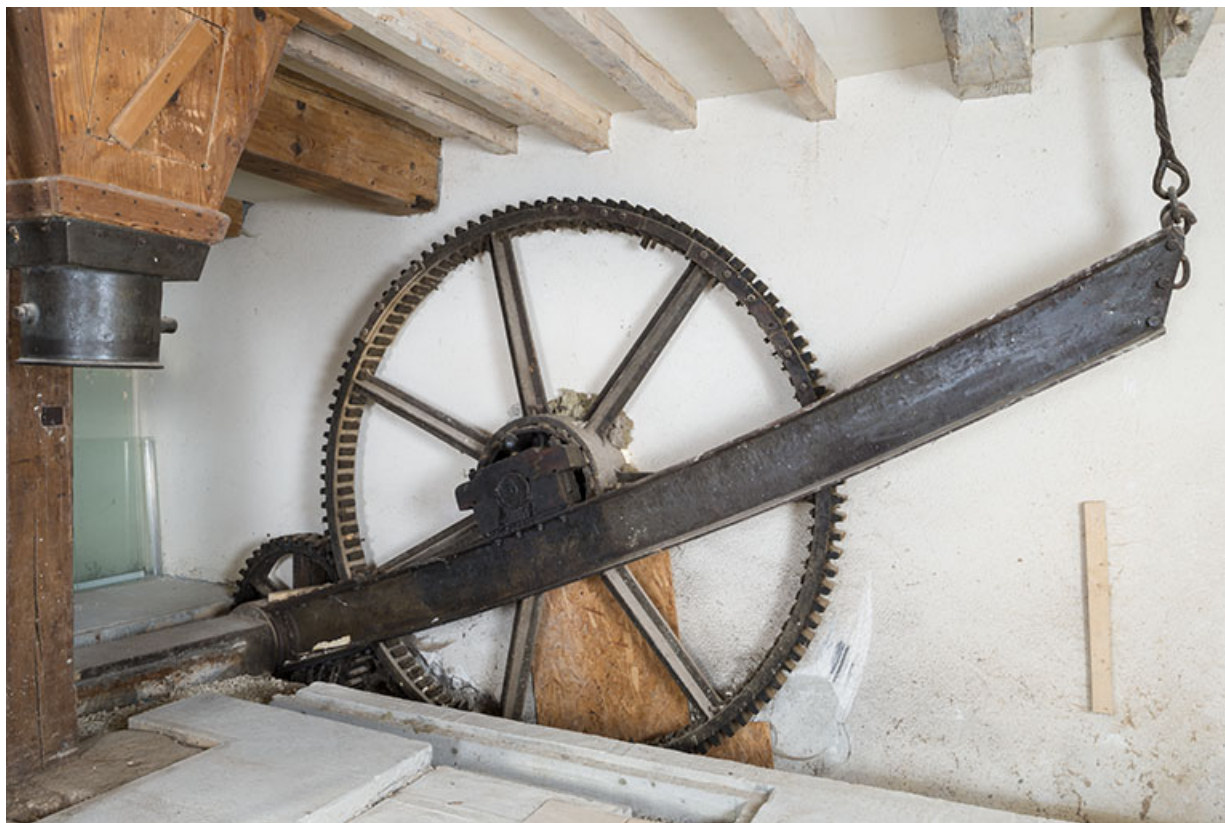
Système de levage de la roue suspendue (amont) : volant engrené (axe de la roue) et levier. 25, Vuillafans, 14, 16 route de Pontarlier
