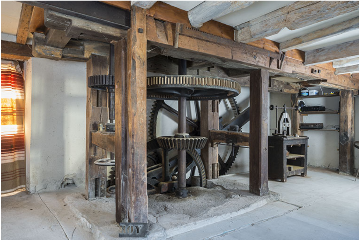
Rez-de-chaussée : beffroi (ouest) des meules.
