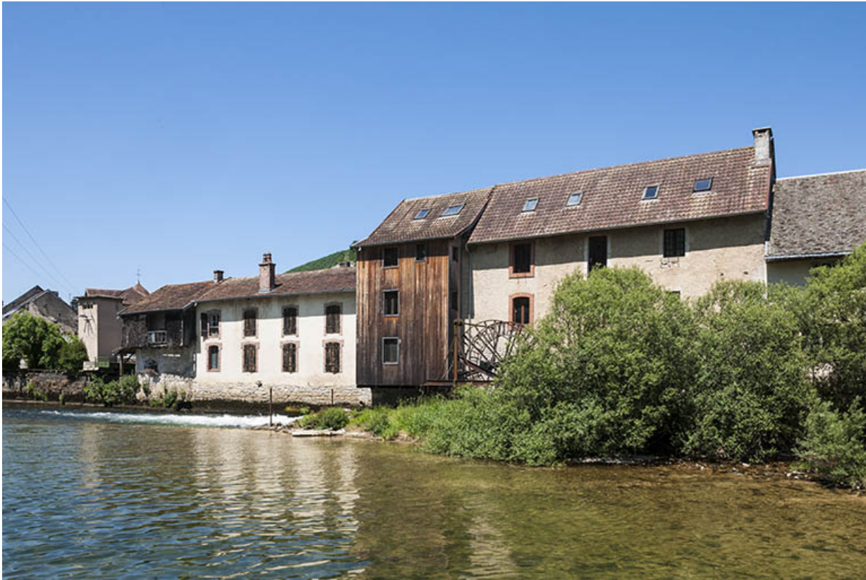
Vue d'ensemble depuis la rive droite.
