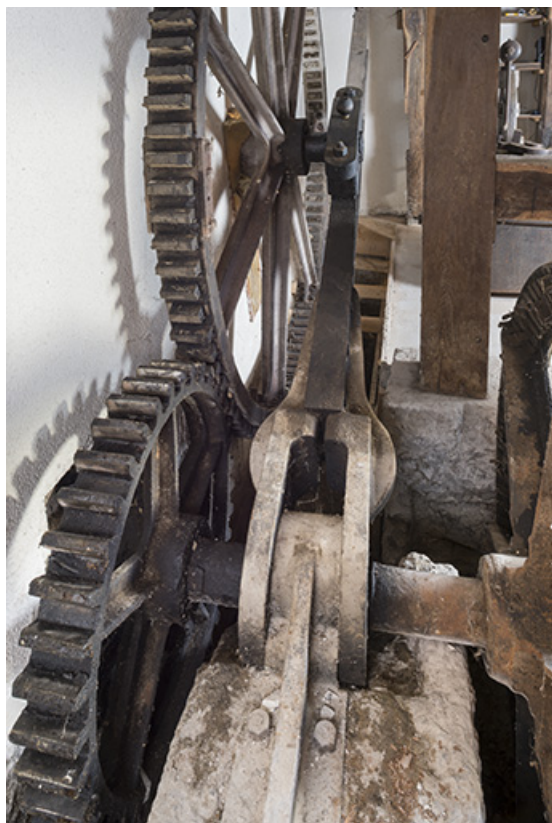
Détail des engrenages du système de levage de la roue suspendue (aval). 25, Vuillafans, 14, 16 route de Pontarlier
