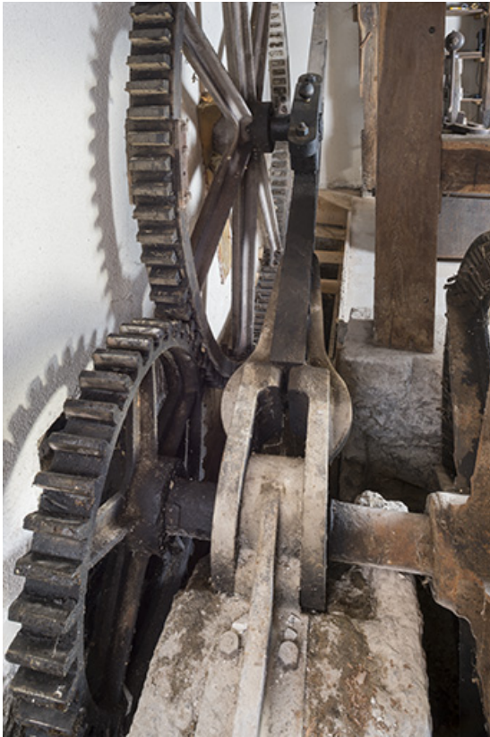
Détail des engrenages du système de levage de la roue suspendue (aval). 25, Vuillafans, 14, 16 route de Pontarlier
