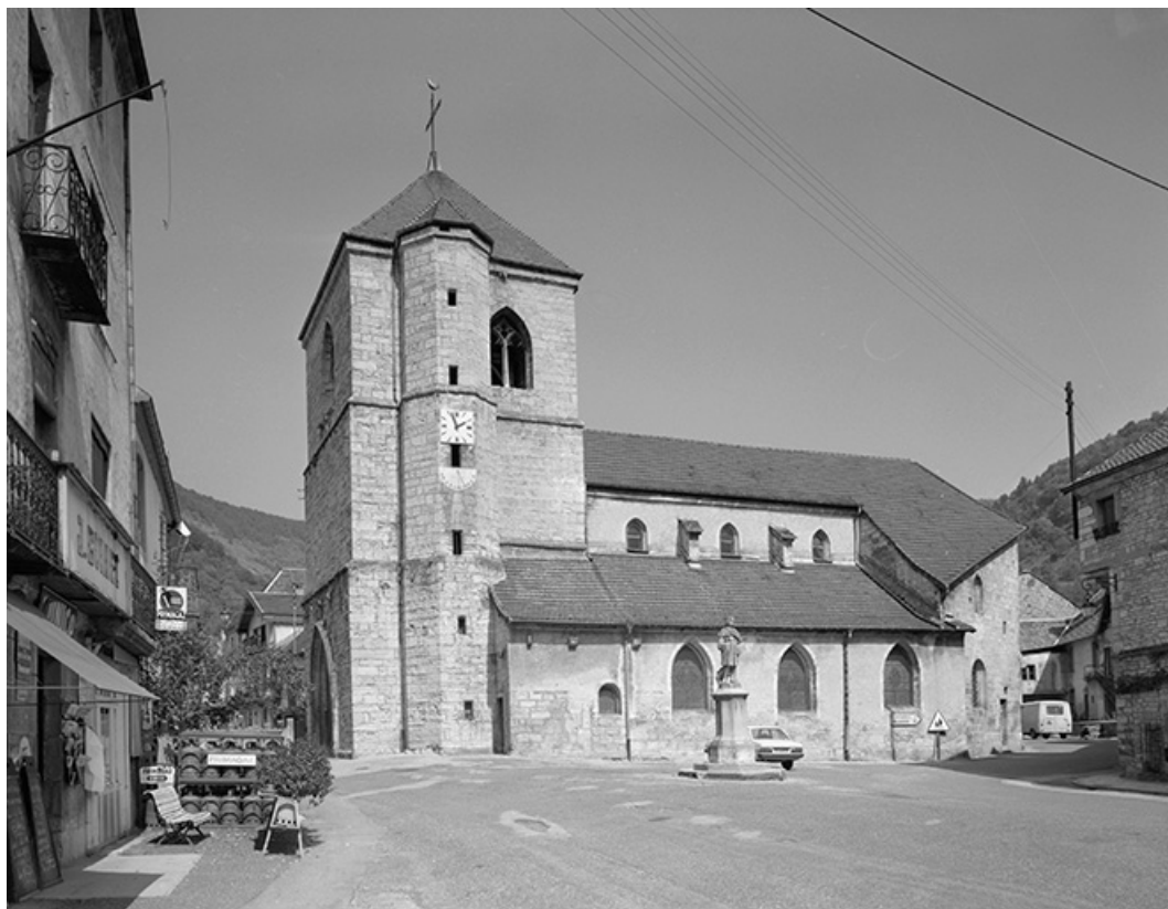
Façade latérale droite vue de trois quarts gauche. 25, Vuillafans
