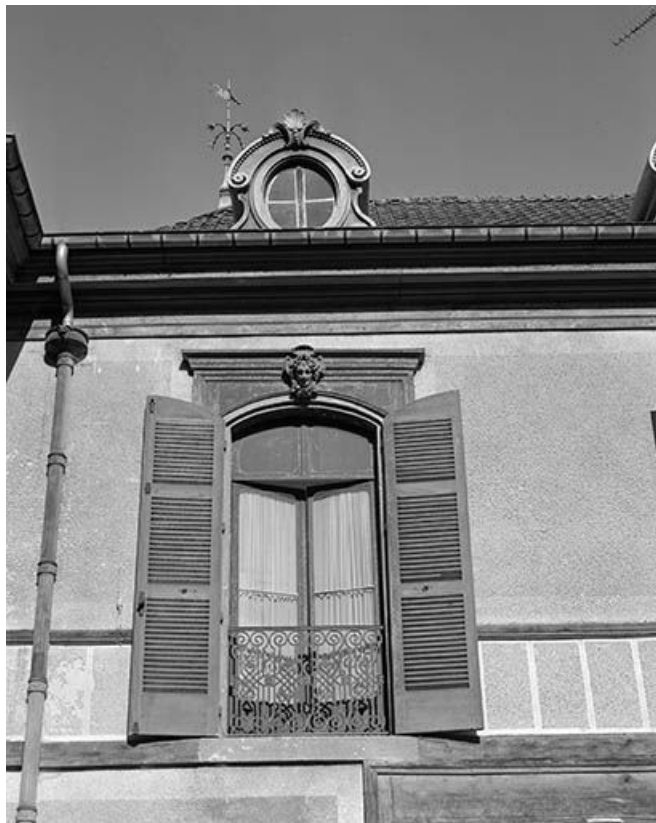
Façade postérieure : une baie du 1er étage.
