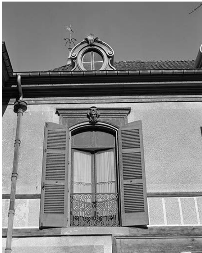
Façade postérieure : une baie du 1er étage.
