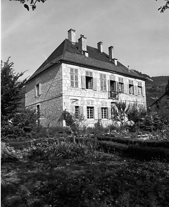
Façade postérieure et face latérale gauche.
