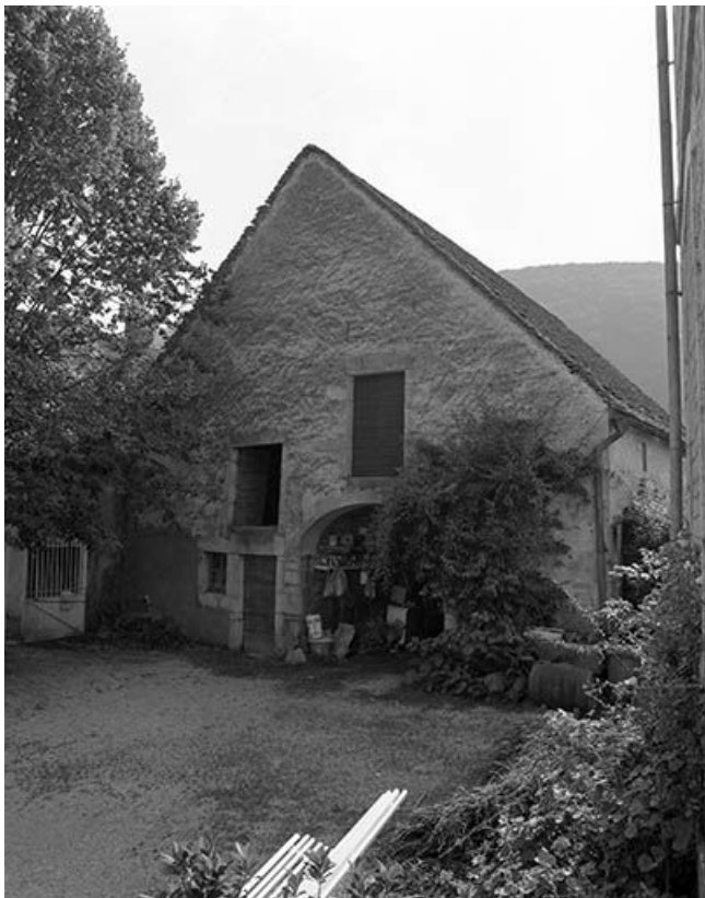
Façade antérieure des parties agricoles.
