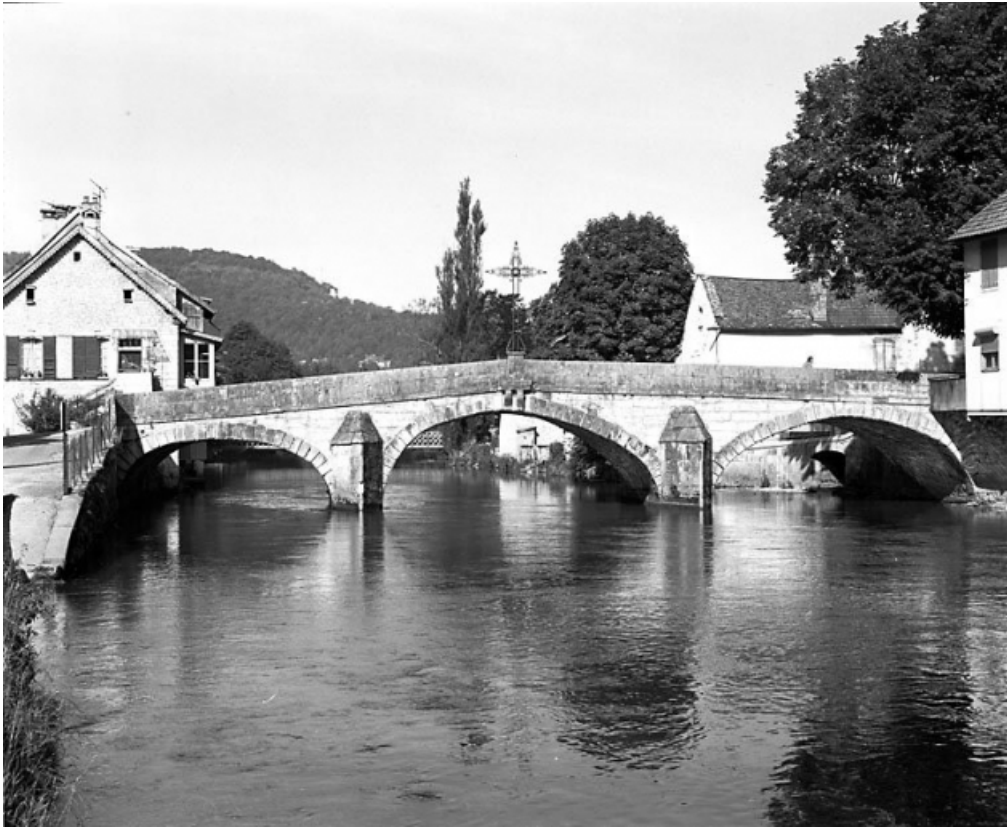
Vue rapprochée depuis la rive gauche. 25, Vuillafans
