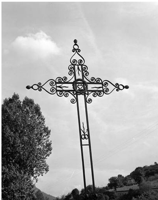
Détail de la croix monumentale.
