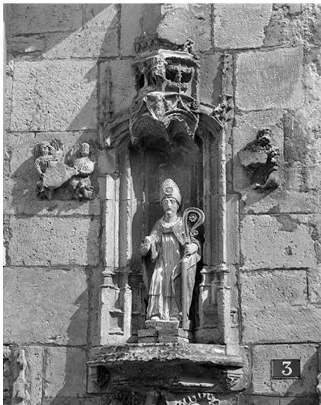
Détail de la façade antérieure : niche au-dessus de la porte d'entrée, vue de face. 25, Vuillafans, 3 rue Gérard
