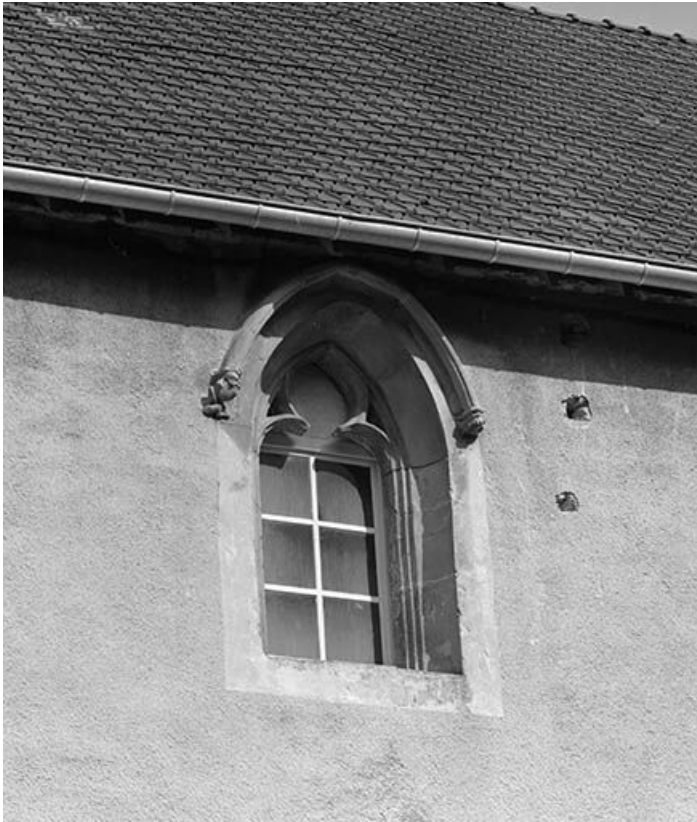
Détail de la façade antérieure : une baie du 1er étage.
