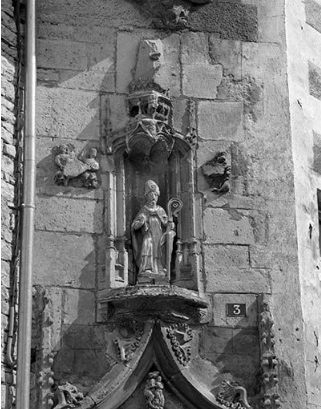
Détail de la façade antérieure : niche au-dessus de la porte d'entrée. 25, Vuillafans, 3 rue Gérard
