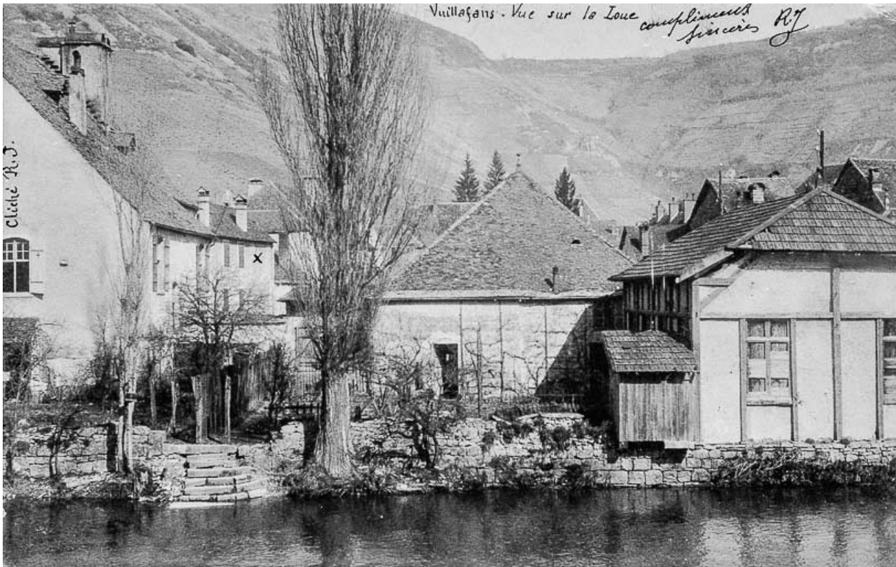
Vue sur la Loue. 25, Vuillafans
