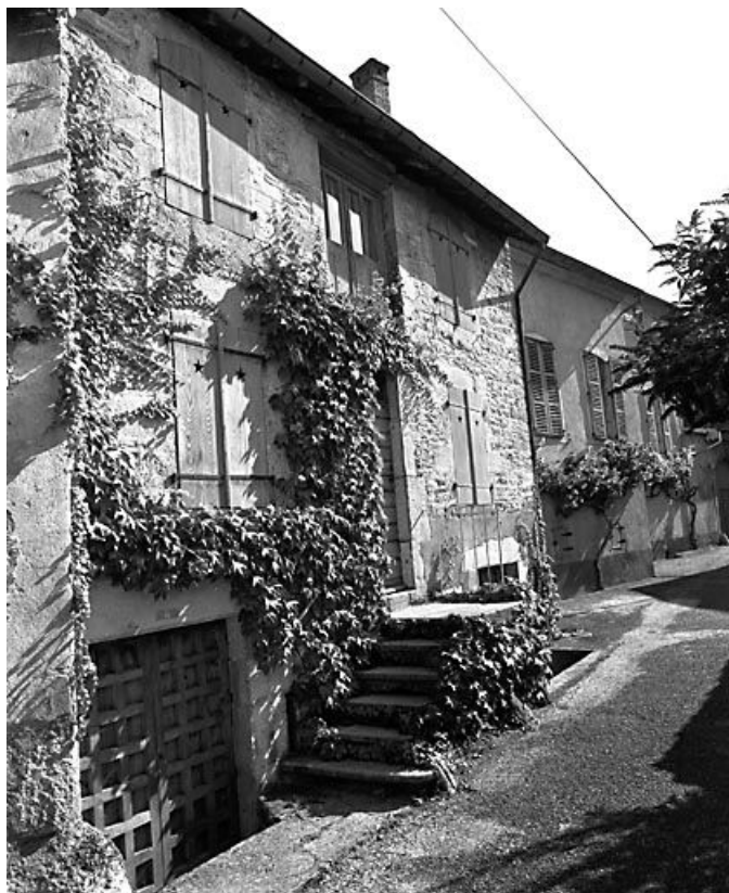
Façade antérieure. 25, Vuillafans
