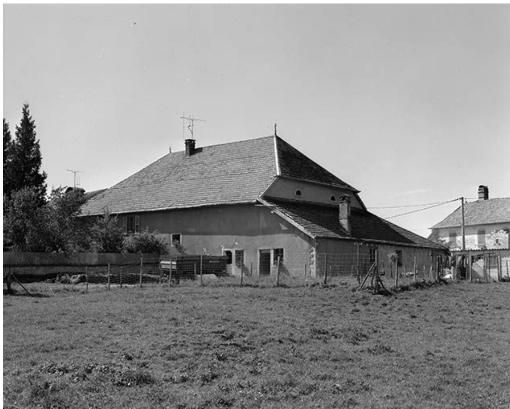
Façade postérieure et face latérale gauche.
