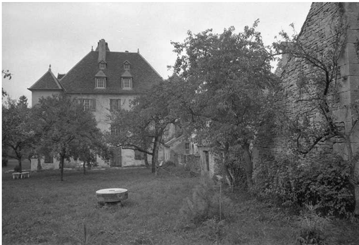
Face latérale droite vue depuis le parc. 25, Villers-sous-Montrond rue de Tarcenay
