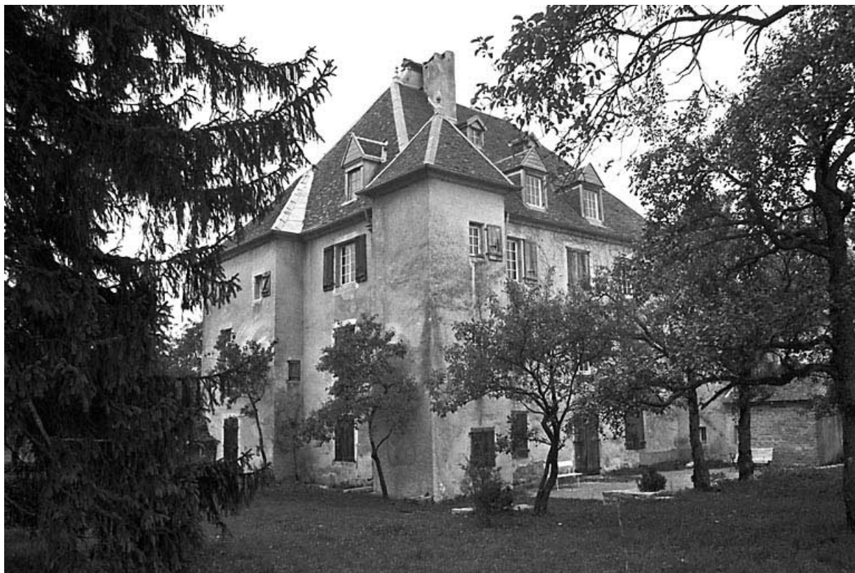
Façade postérieure et face latérale droite depuis le parc.
