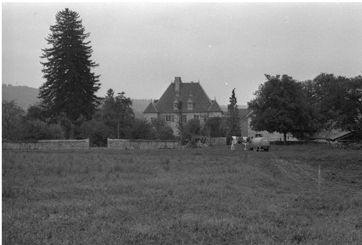
Façade postérieure et façade latérale droite depuis le parc : vue rapprochée. 25, Villers-sous-Montrond rue de Tarcenay
