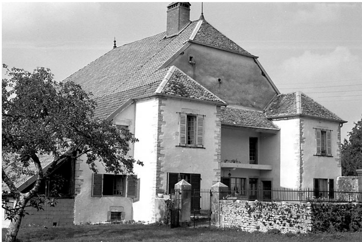
Façade antérieure vue de trois quarts gauche.
