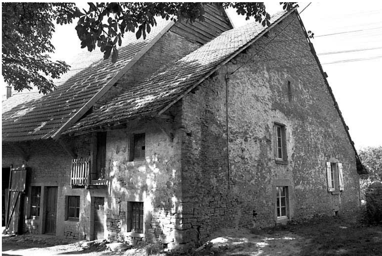
Façade antérieure et face latérale droite.
