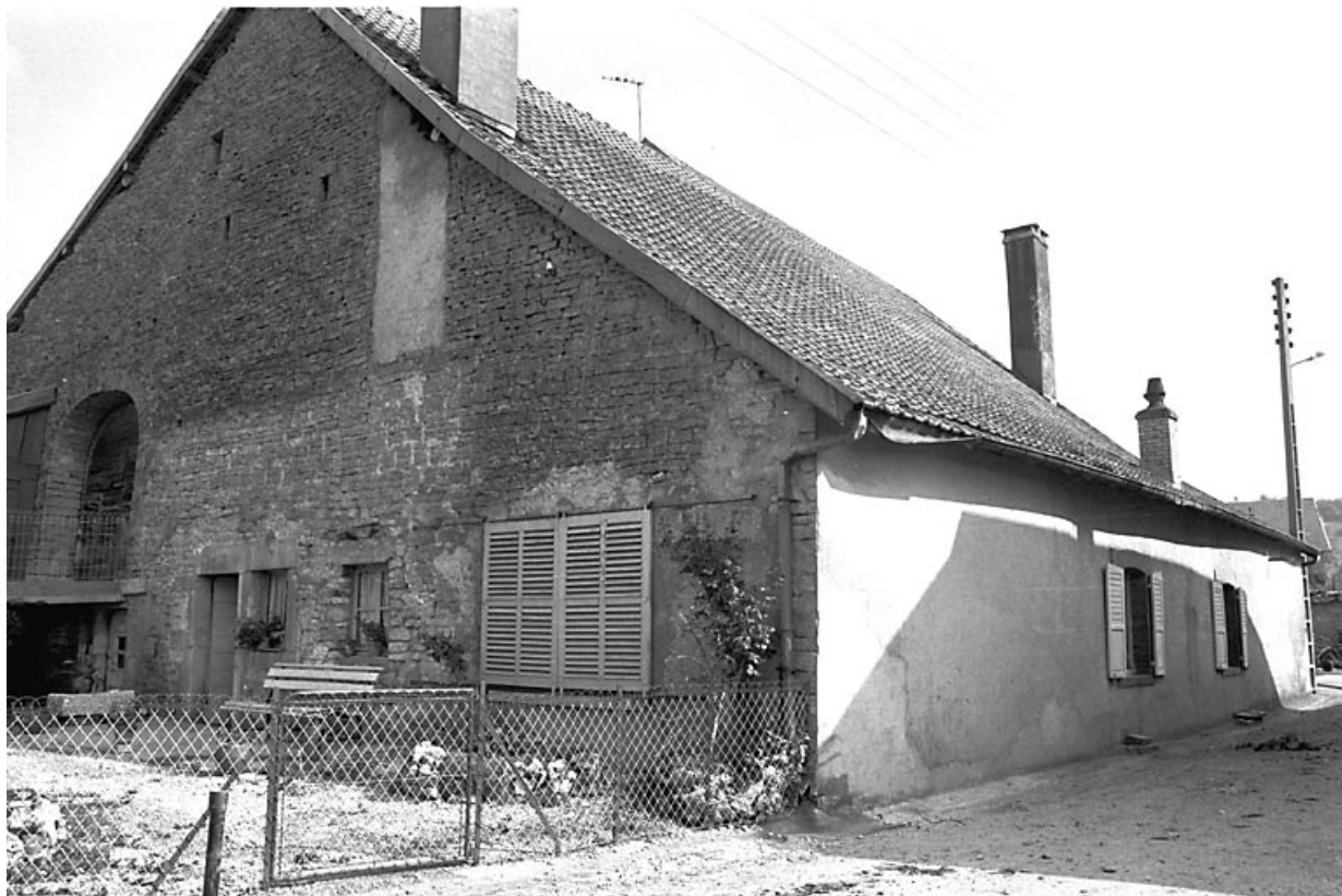
Façade postérieure et face latérale gauche.
