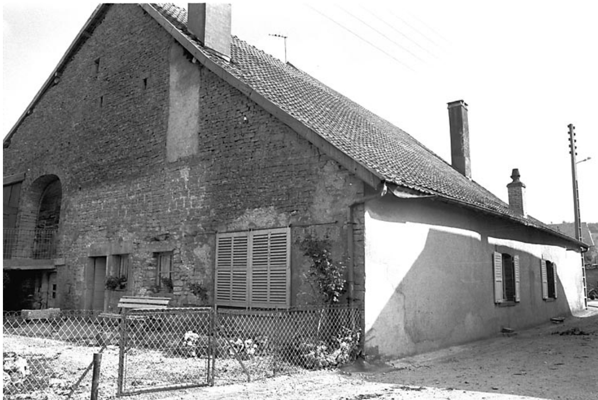
Façade postérieure et face latérale gauche.
