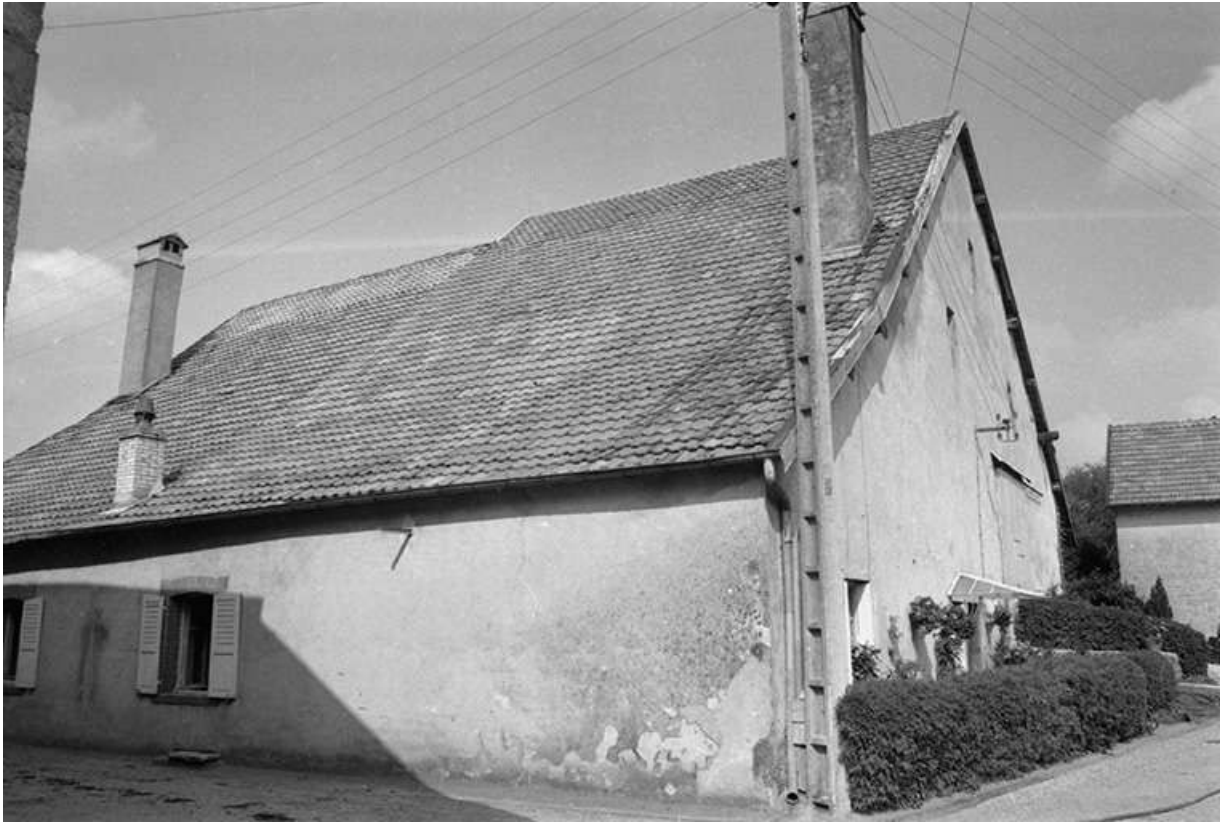
Façade antérieure et face latérale gauche. 25, Villers-sous-Montrond
