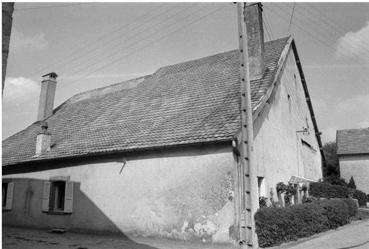
Façade antérieure et face latérale gauche. 25, Villers-sous-Montrond
