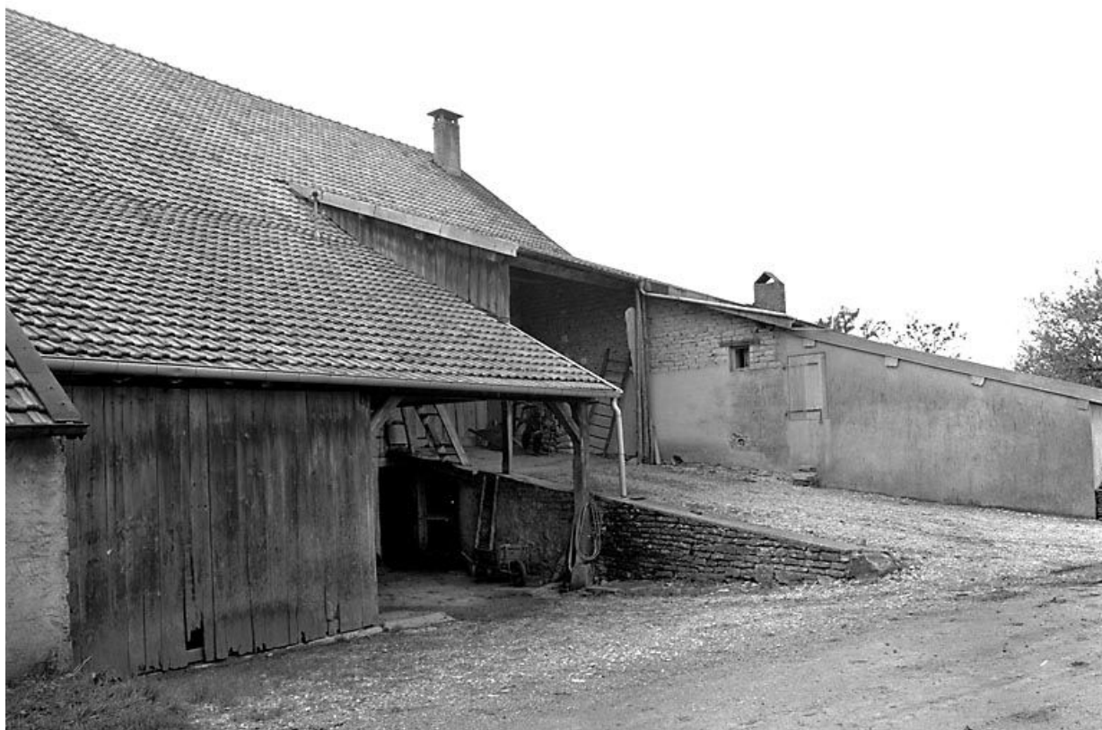
Façade latérale gauche : le pont de grange.
