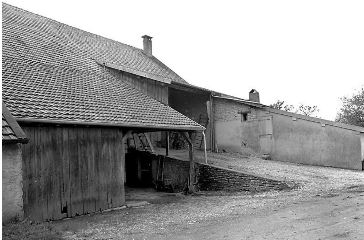
Façade latérale gauche : le pont de grange.
