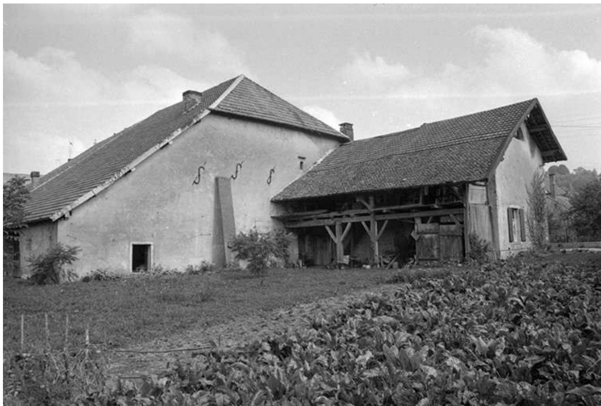
Ferme cadastrée 1969 AB 64, 65, située rue de l'Eglise (?) : façade postérieure. 25, Villers-sous-Montrond
