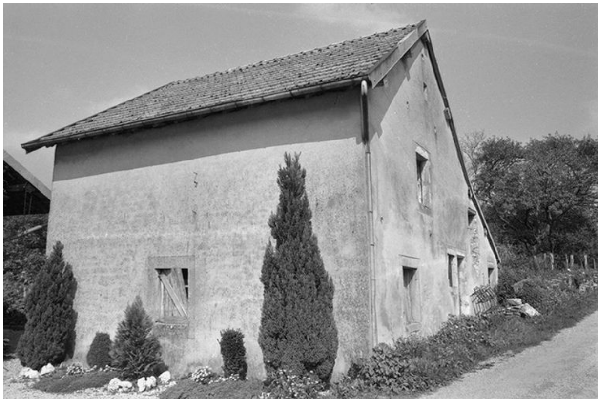
Ferme située rue de l'Eglise (?) : façade antérieure et face latérale gauche. 25, Villers-sous-Montrond
