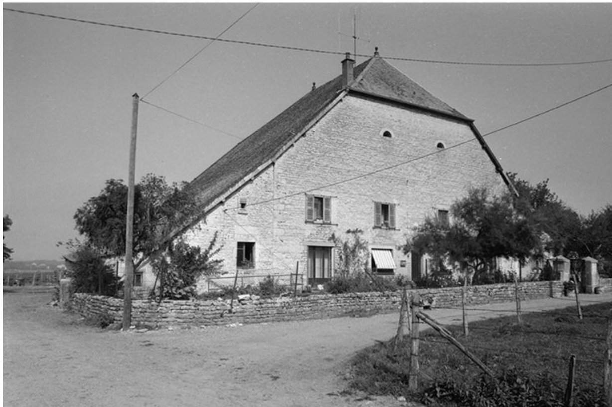
Ferme située rue du Camp : façade antérieure. 25, Villers-sous-Montrond
