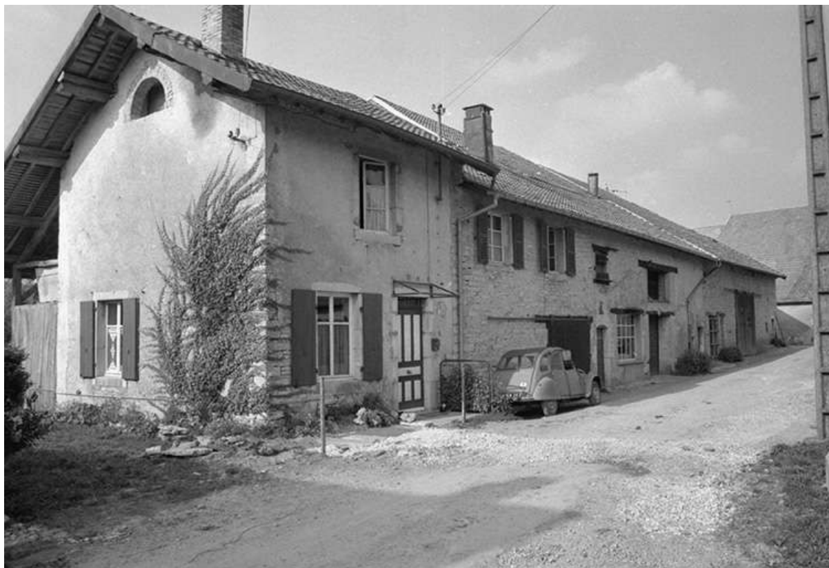
Maisons situées rue de l'Eglise : façade antérieure et face latérale gauche. 25, Villers-sous-Montrond
