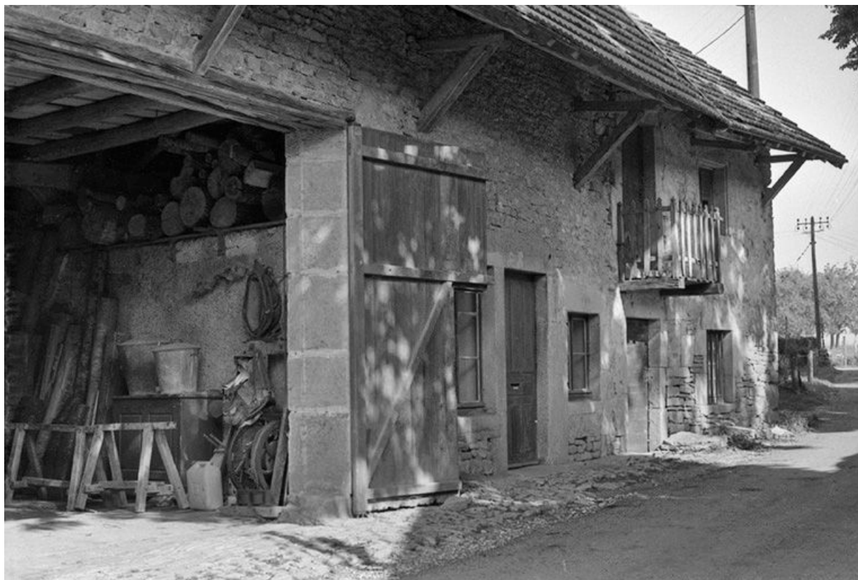
Façade antérieure vue de trois quarts gauche.
