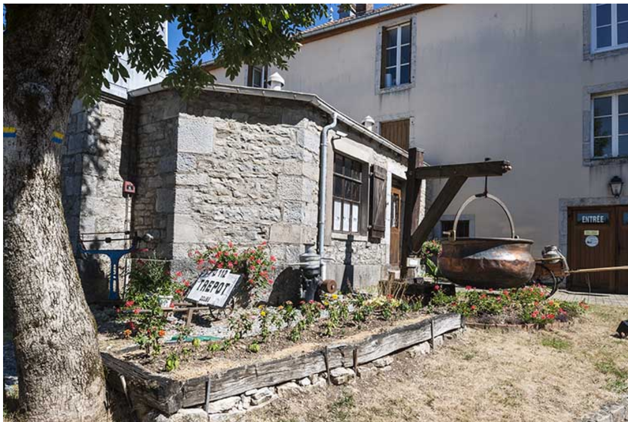
Atelier de fromagerie et façade postérieure de la mairie.
