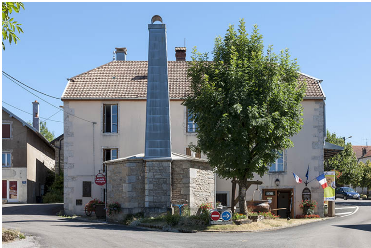
Vue d'ensemble depuis le nord. Cheminée de la chaufferie au premier plan. 25, Trépot, 3 place de la Mairie
