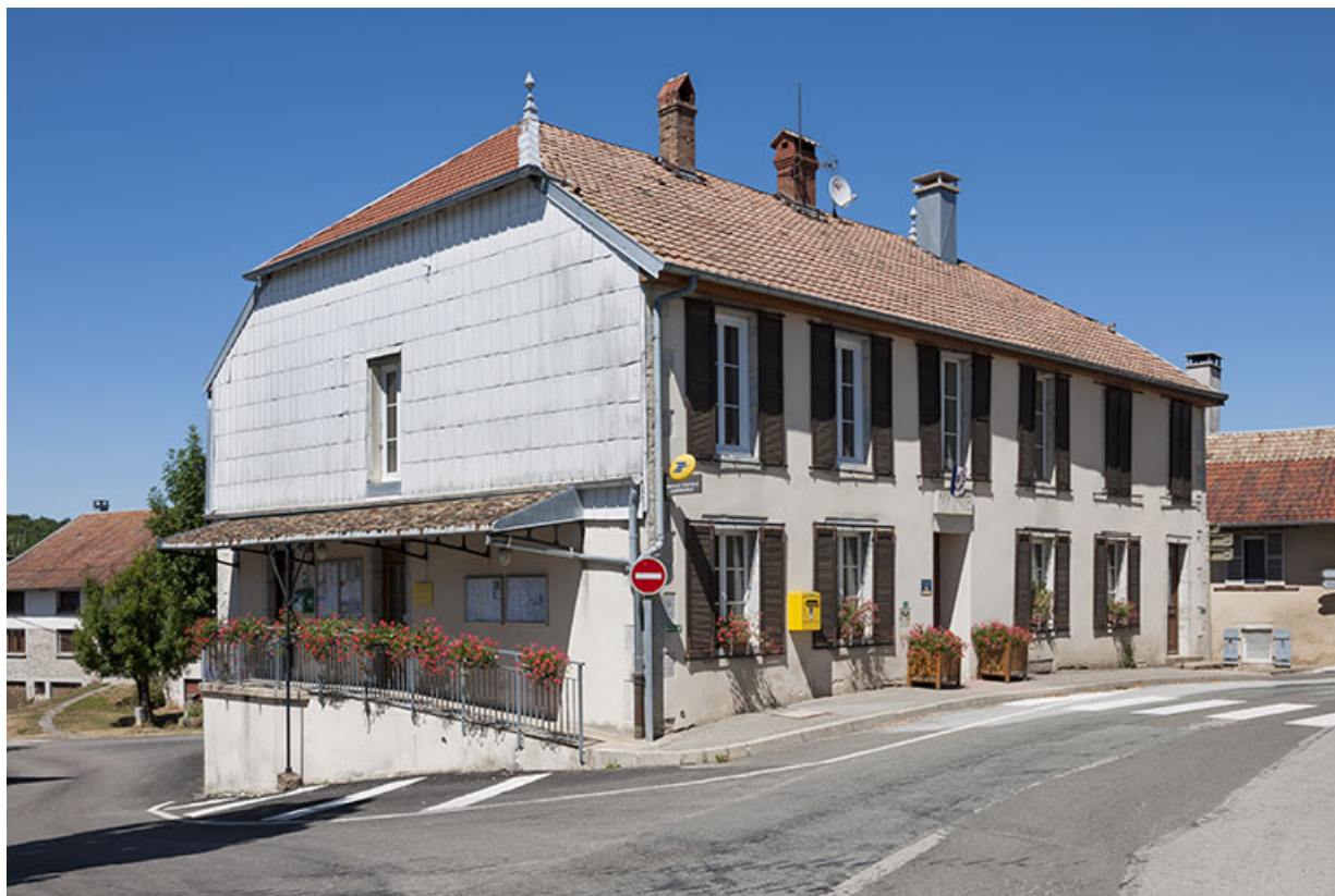
Vue d'ensemble depuis le sud.
