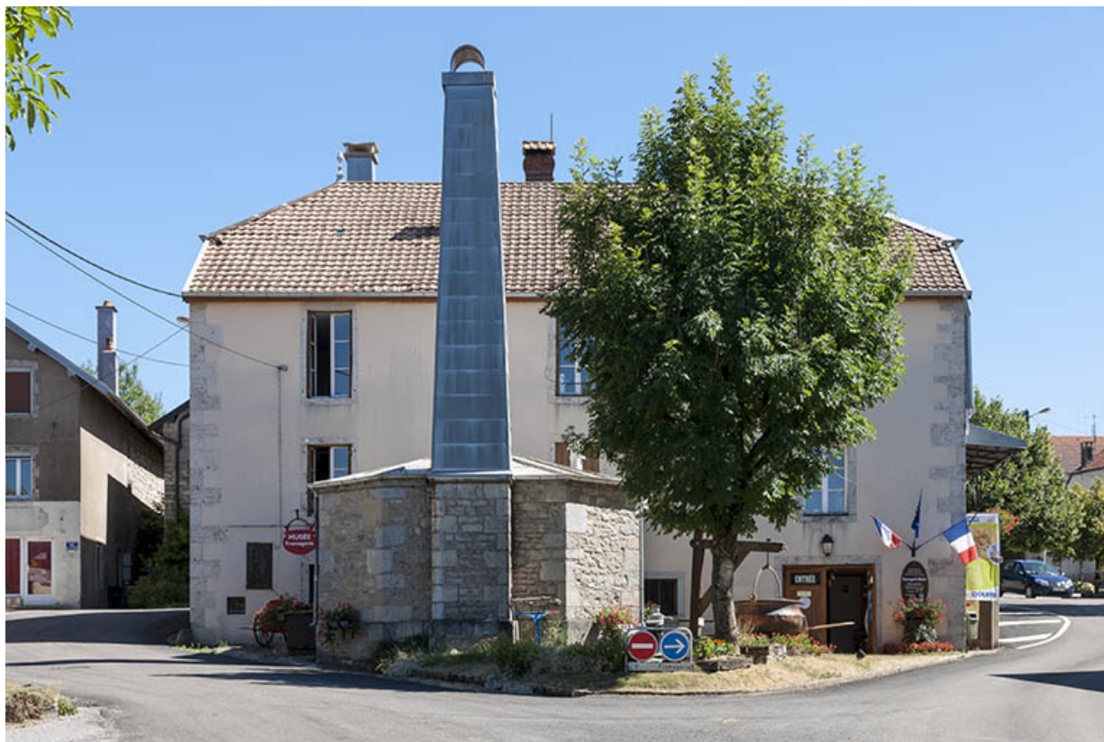
Vue d'ensemble depuis le nord. Cheminée de la chaufferie au premier plan. 25, Trépot, 3 place de la Mairie
