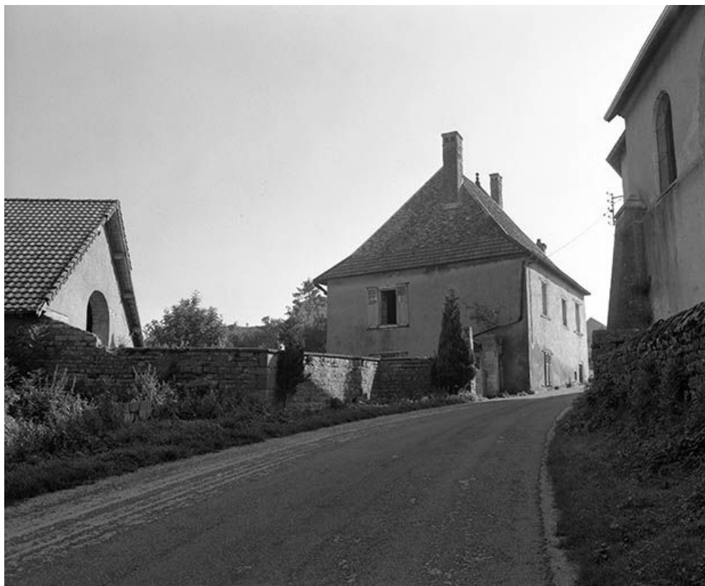
Vue d'ensemble depuis la rue. 25, Trépot
