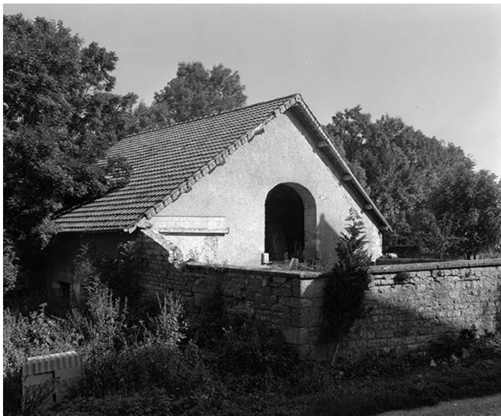
Façade antérieure des parties agricoles.
